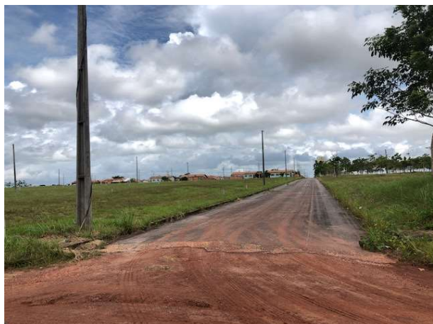
FOTO 37: AVENIDA DAS ROSAS
