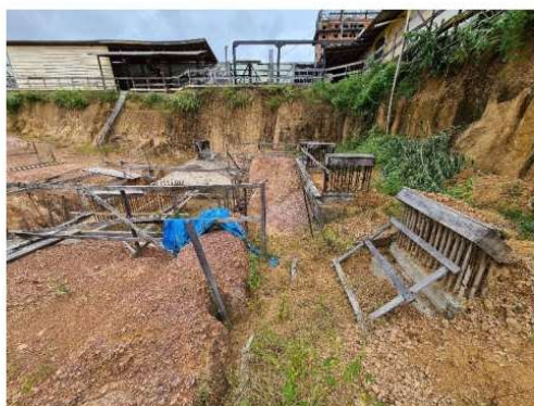
FOTO 12: FUNDAÇÕES PARCIALMENTE EXECUTADAS.
