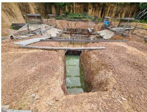
FOTO 17: ESCAVAÇÃO DAS FUNDAÇÕES.
