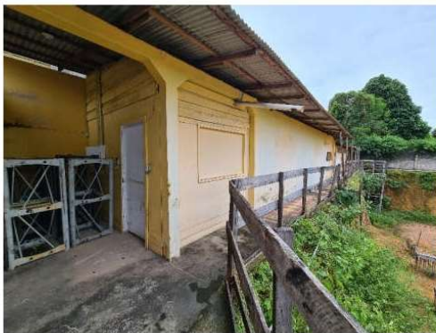
FOTO 07: CANTEIRO DE OBRAS
