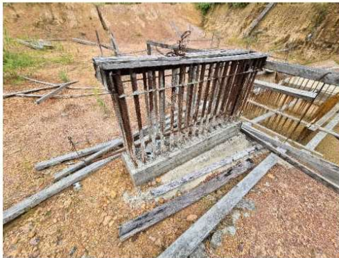
FOTO 13: FUNDAÇÕES DO TIPO SAPATA.
