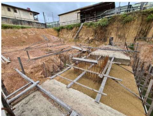
FOTO 14: FUNDAÇÕES DO TIPO SAPATA.
