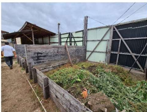
FOTO 08: LOCAL DE ARMAZENAMENTO DE AGREGADOS
