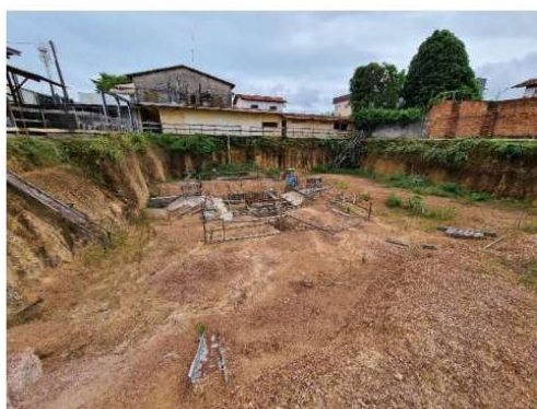
FOTO 11: ESCAVAÇÃO DO SUBSOLO PARCIAL.
