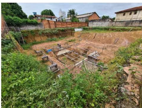
FOTO 06: ESCAVAÇÃO DO SUBSOLO
