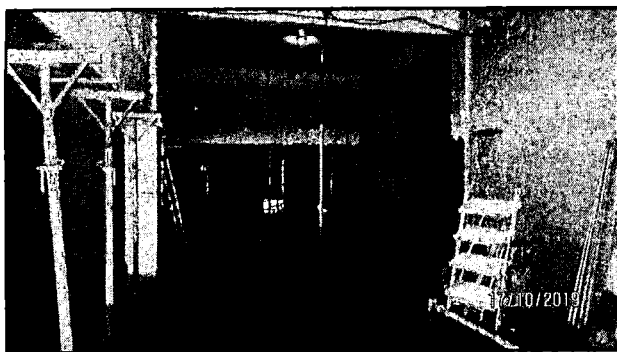
Foto 17: Vista interna de Bloco
