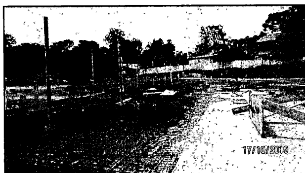
Foto 19: Laje de Bloco parcialmente concretada
