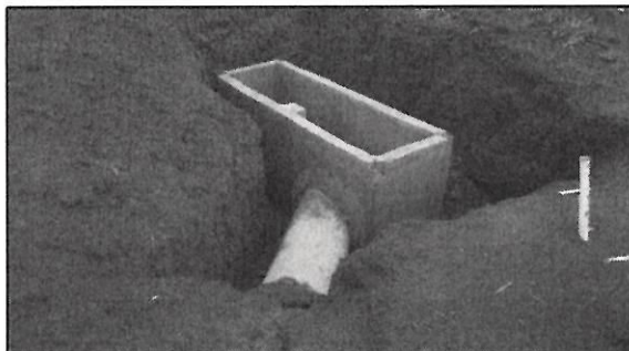
Foto 15: Boca de Lobo (BL) da Rua 08 - Fase 2
