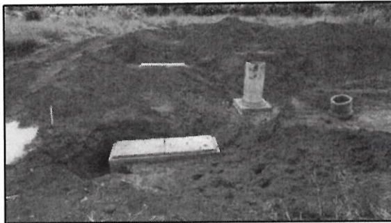
Foto 17: BL e PV da Rua 01 - Fase 4
