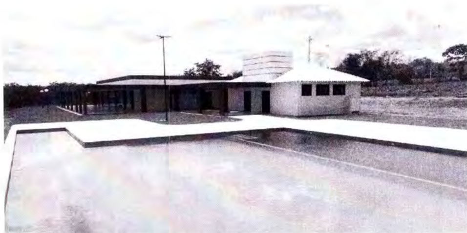
FOTO 04: PISCINAS DO CLUBE
