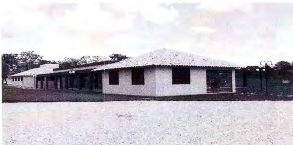
FOTO 17: FACHADA FRONTAL SALÃO DE FESTAS
