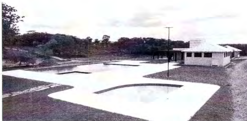
FOTO 02: PISCINAS DO CLUBE
