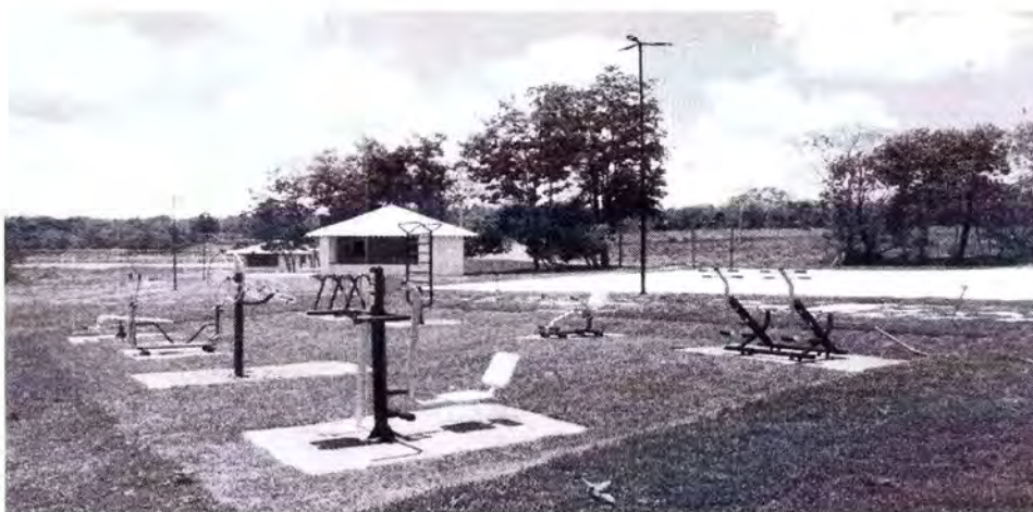
FOTO 18: ACADEMIA AO AR LIVRE COM BASES E INSTALAÇÃO CONCLUÍDAS.
