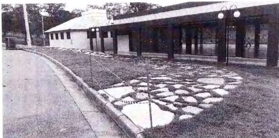
FOTO 13: PASSARELA PARA VEÍCULO EM SALÃO DE FESTAS CONCLUÍDA.
