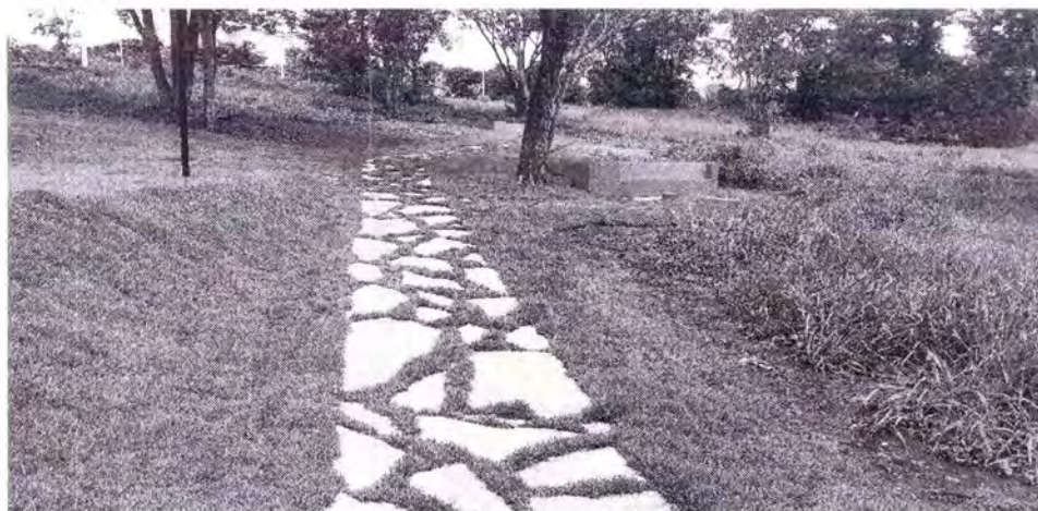
FOTO 03: PASSARELAS CONCLUÍDAS ENTRE OS "FOGOS DE CHÃO"
