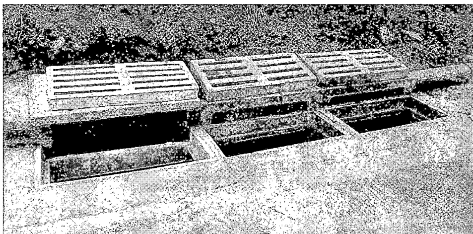
FOTO 12: AMPLIAÇÃO DA BOCA DE BUEIRO PARA AUMENTO DA CAPACIDADE DE CARGA.
