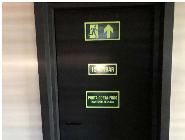
FOTO 86: 12º PAVIMENTO - SAÍDA DE EMERGÊNCIA. PORTA CORTA-FOGO
