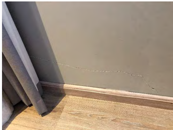
FOTO 38: SUÍTE 135: TRINCA NA PAEDE
