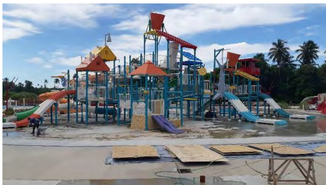
FOTO 25: PARQUE AQUÁTICO EM CONSTRUÇÃO
