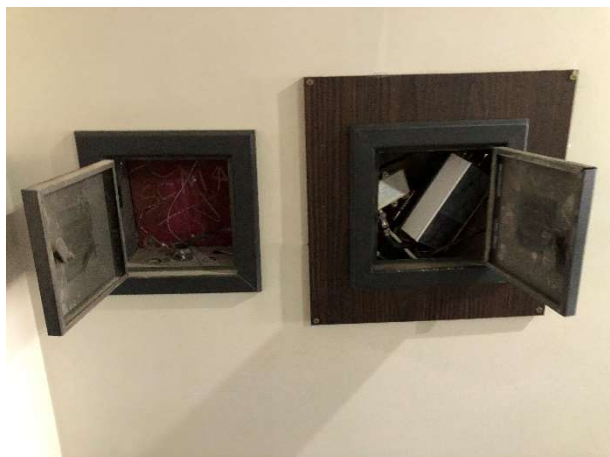
FOTO 85: 12º PAVIMENTO - CAIXAS DE INSPEÇÃO DAS INSTALAÇÕES DE REDES
