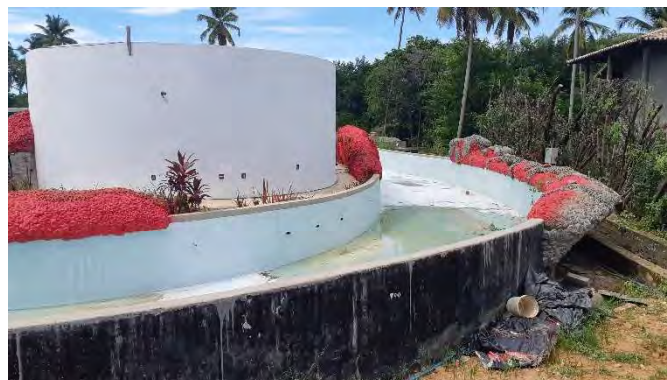
FOTO 26: PARQUE AQUÁTICO EM CONSTRUÇÃO
