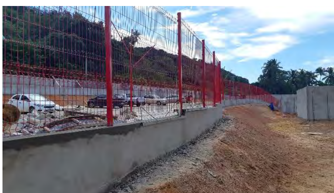
FOTO 23: PARQUE AQUÁTICO EM CONSTRUÇÃO
