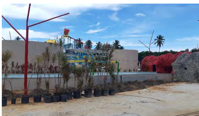
FOTO 24: PARQUE AQUÁTICO EM CONSTRUÇÃO
