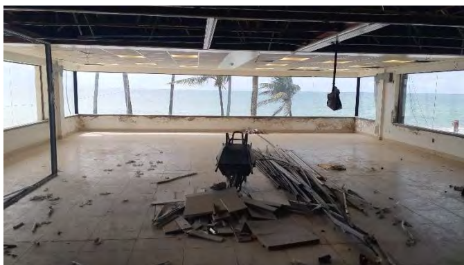
FOTO 15: SALA WYNDHAM EM REFORMA
