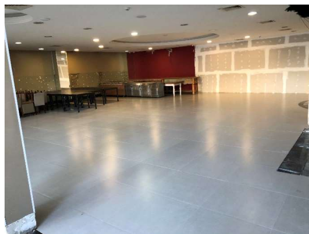
FOTO 120: TÉRREO – RESTAURANTE EM REFORMA
