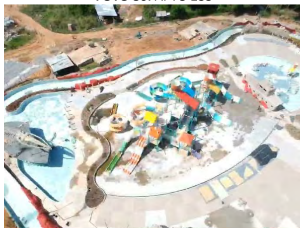
FOTO 88: VISTA AÉREA – PQ AQUÁTICO EM CONSTRUÇÃO
