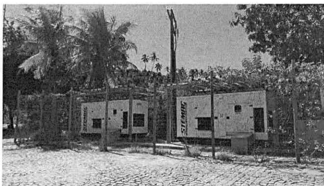
FOTO 58: GERADORES NA ENTRADA
