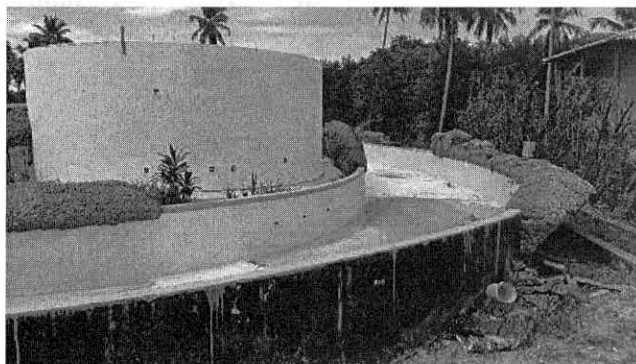
FOTO 26: PARQUE AQUÁTICO EM CONSTRUÇÃO
