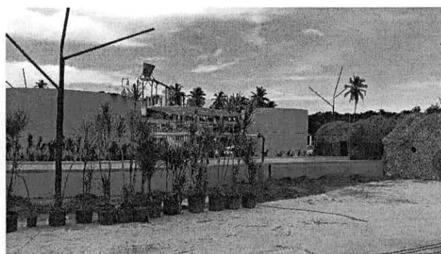
FOTO 24: PARQUE AQUÁTICO EM CONSTRUÇÃO
