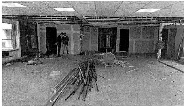
FOTO 16: SALA WYNDHAM EM REFORMA
