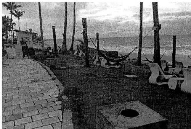
FOTO 01: ESTRUTURA DE PRAIA DO RESORT
