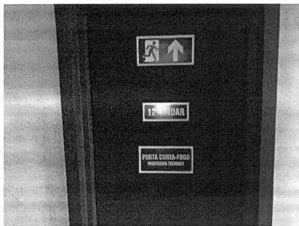
FOTO 86: 12º PAVIMENTO - SAÍDA DE EMERGÊNCIA. PORTA CORTA-FOGO
