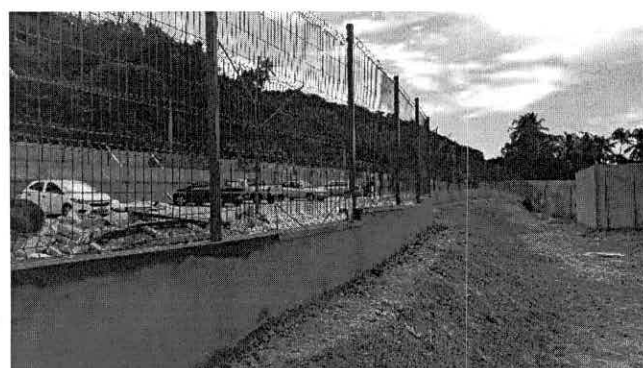
FOTO 23: PARQUE AQUÁTICO EM CONSTRUÇÃO
