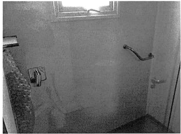
FOTO 68: BANHEIRO DA SUÍTE 335
