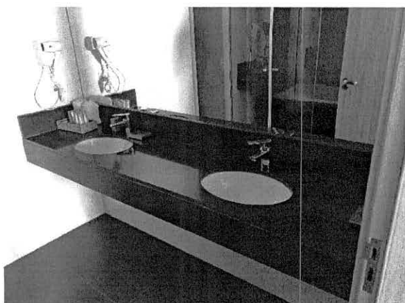
FOTO 101: BANHEIRO DA SUÍTE 245
