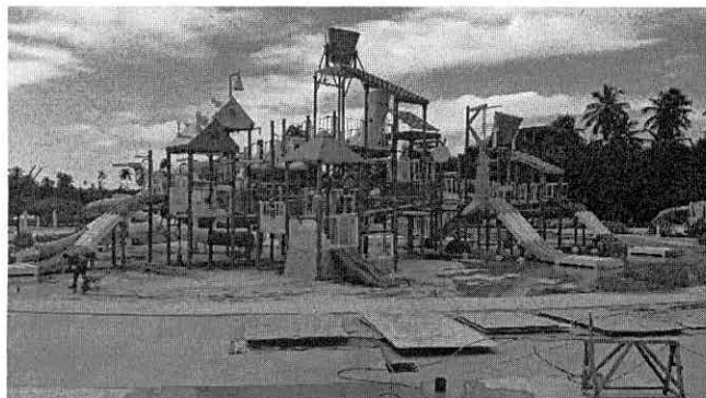
FOTO 25: PARQUE AQUÁTICO EM CONSTRUÇÃO
