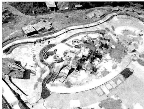
FOTO 88: VISTA AÉREA – PQ AQUÁTICO EM CONSTRUÇÃO
