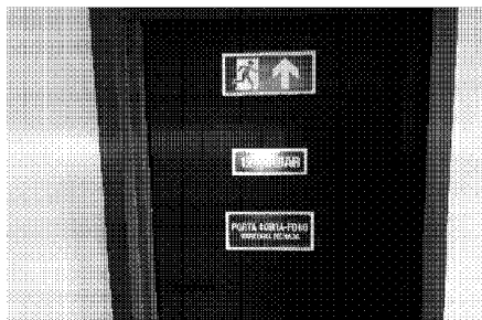
FOTO 86: 12º PAVIMENTO - SAÍDA DE EMERGÊNCIA. PORTA CORTA-FOGO
