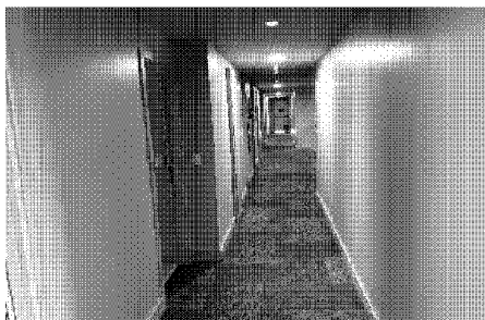
FOTO 103: TORRE 2, 3º PAVIMENTO - HALL
