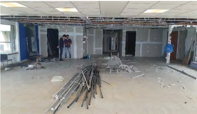
FOTO 16: SALA WYNDHAM EM REFORMA
