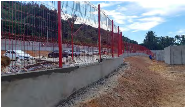
FOTO 23: PARQUE AQUÁTICO EM CONSTRUÇÃO
