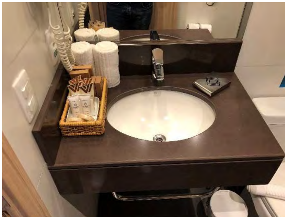
FOTO 35: BANHEIRO DA SUÍTE 121
