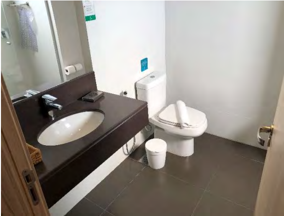
FOTO 41: BANHEIRO DA SUÍTE 135
