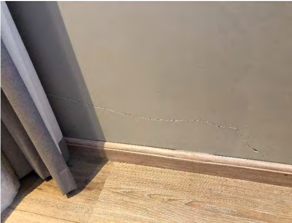
FOTO 38: SUÍTE 135: TRINCA NA PAEDE
