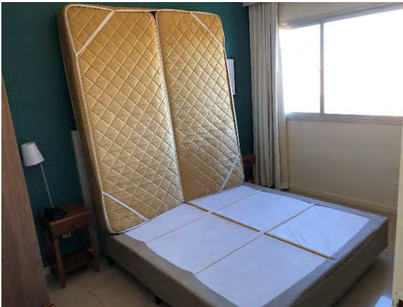
FOTO 27: APT Nº 1107 - REPARO A SER REALIZADO
