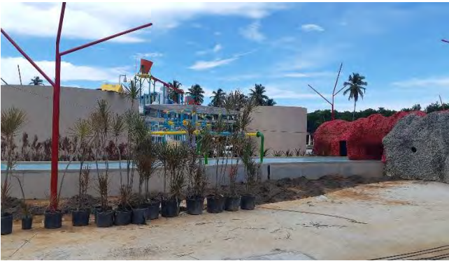
FOTO 24: PARQUE AQUÁTICO EM CONSTRUÇÃO
