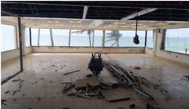
FOTO 15: SALA WYNDHAM EM REFORMA
