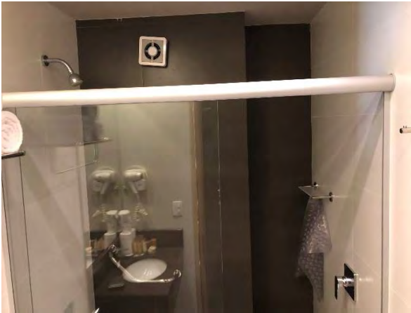
FOTO 49: BANHEIRO DA SUÍTE 221
