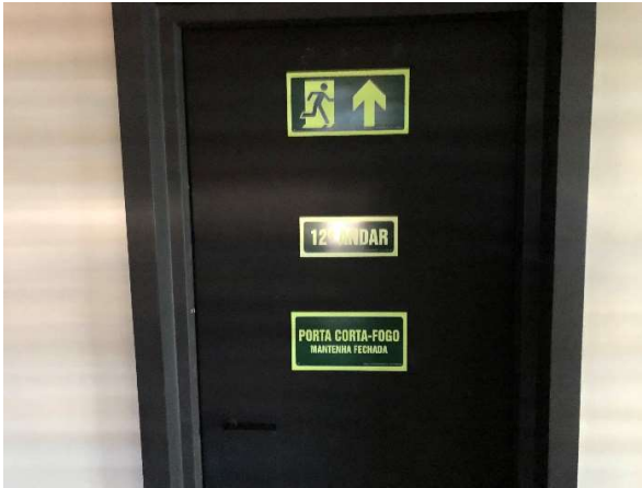
FOTO 86: 12º PAVIMENTO - SAÍDA DE EMERGÊNCIA. PORTA CORTA-FOGO
