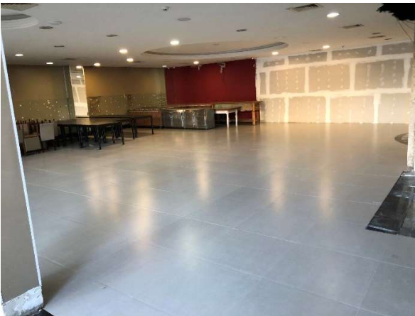
FOTO 120: TÉRREO – RESTAURANTE EM REFORMA
