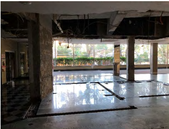
FOTO 119: TÉRREO – RESTAURANTE EM REFORMA
