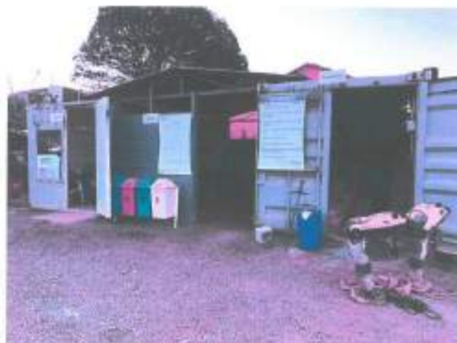
FOTO 30: INSTALAÇÕES PROVISÓRIAS DO CANTEIRO DE OBRAS.
