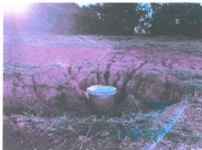
FOTO 11: RUA 06 – PV DE ESGOTO.
