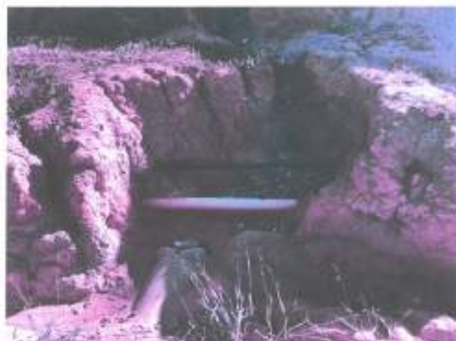
FOTO 05: RUA 02 – REDES DE ÁGUA E ESGOTO.
