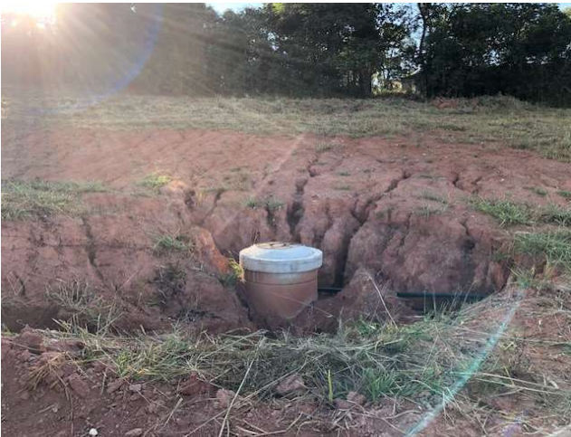
FOTO 11: RUA 06 – PV DE ESGOTO.
