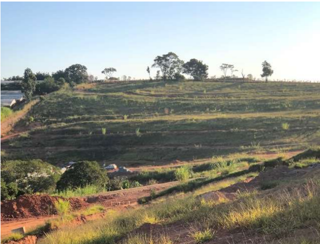
FOTO 21: VISTA DO LOTEAMENTO PELA RUA 02.
