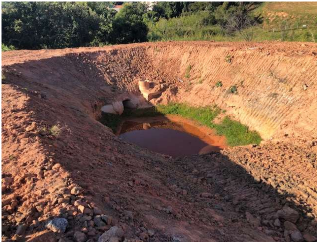
FOTO 04: RUA 02 – LAGOA PROVISÓRIA DE AMORTECIMENTO DE ÁGUAS PLUVIAIS.
