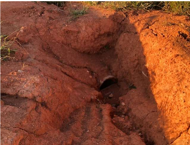
FOTO 23: RUA 03 – PV DE ESGOTO.
