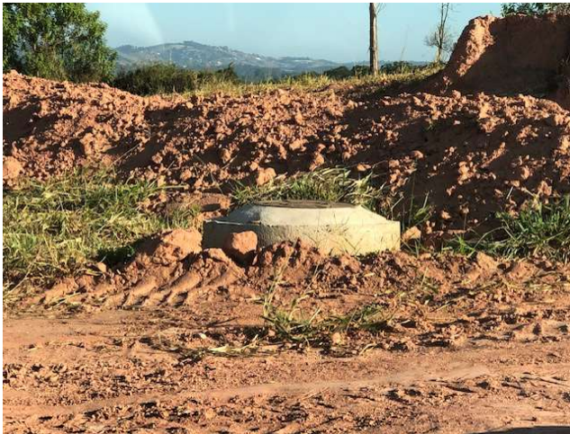
FOTO 13: RUA 09 – PV DE ESGOTO.
