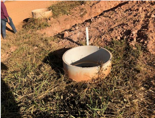
FOTO 02: RUA 08 – PV. DE ESGOTO.
