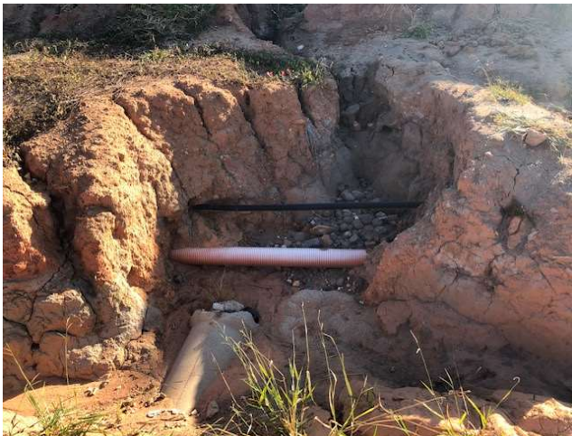
FOTO 05: RUA 02 – REDES DE ÁGUA E ESGOTO.
