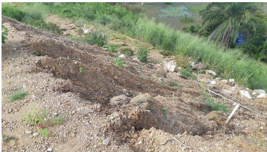
FOTO 07: ESCAVAÇÃO DE MATERIAL DA 2ª FASE – ETAPA 1.
