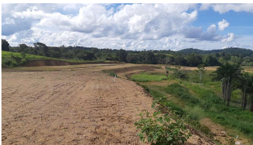
FOTO 12: TERRAPLANAGEM E LIMPEZA DA 2ª FASE – ETAPA 1.
