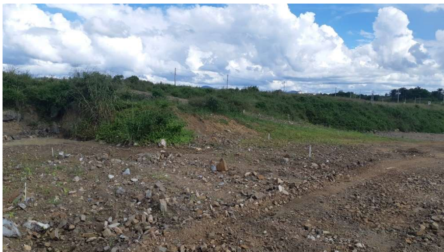
FOTO 04: TERRAPLANAGEM DA 2ª FASE – ETAPA 1.
