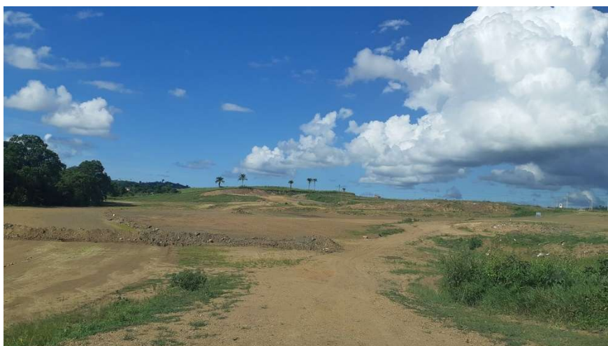
FOTO 15: TERRAPLANAGEM E LIMPEZA DA 2ª FASE – ETAPA 1.
