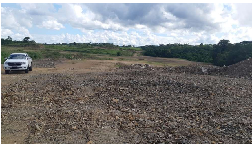
FOTO 03: TERRAPLANAGEM E ESCAVAÇÃO DA 2ª FASE – ETAPA 1..
