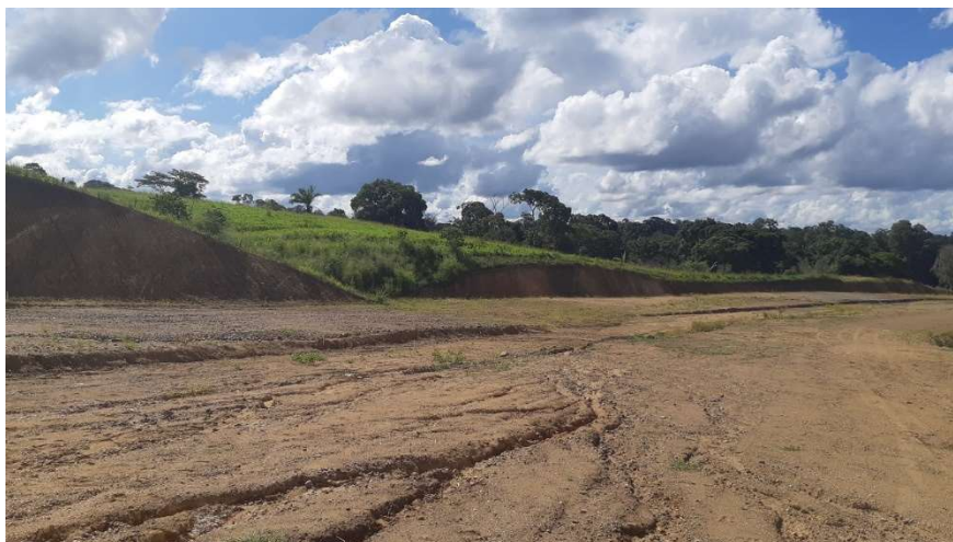
FOTO 13: TERRAPLANAGEM DA 2ª FASE – ETAPA 1.
