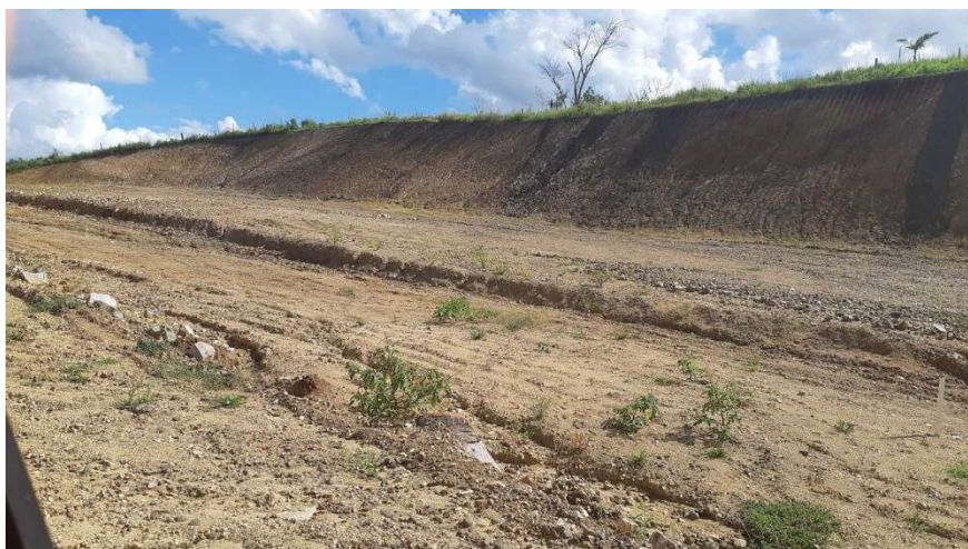
FOTO 14: TERRAPLANAGEM DA 2ª FASE – ETAPA 1.
