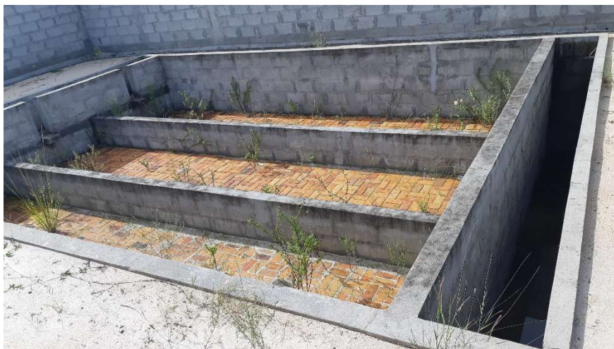
FOTO 11: ESTAÇÃO COMPACTA DE TRATAMENTO DE ESGOTO SANITÁRIO.
