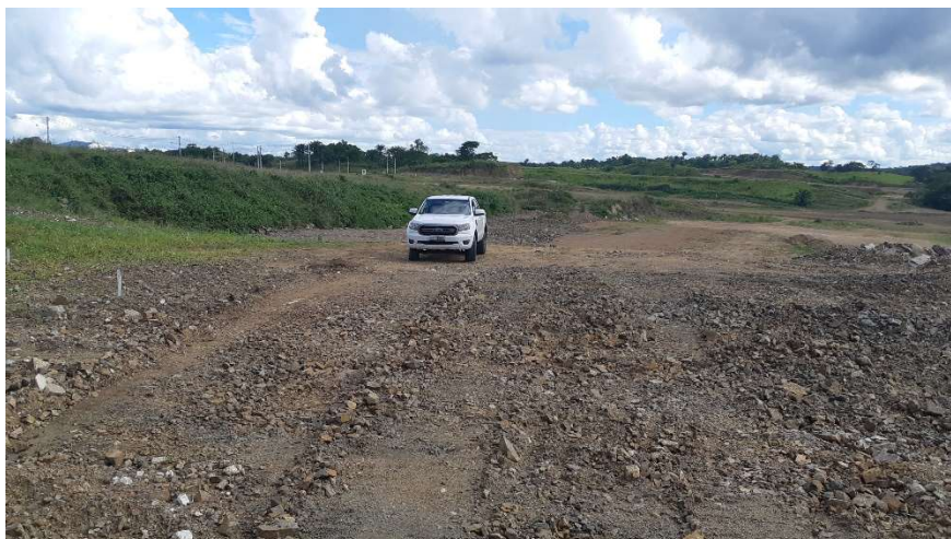
FOTO 17: TERRAPLANAGEM E LIMPEZA DA 2ª FASE – ETAPA 1.
