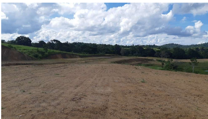
FOTO 06: TERRAPLANAGEM E LIMPEZA DA 2ª FASE – ETAPA 1.
