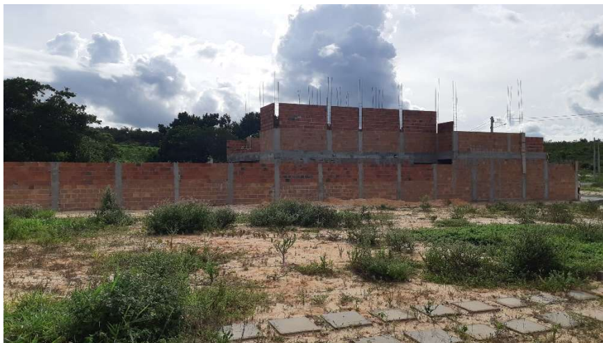
FOTO 46: CASA EM CONSTRUÇÃO NO EMPREENDIMENTO.
