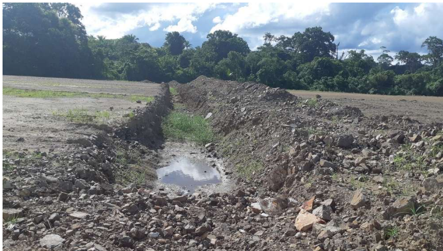
FOTO 16: ESCAVAÇÃO DE MATERIAL DA 2ª FASE – ETAPA 1.
