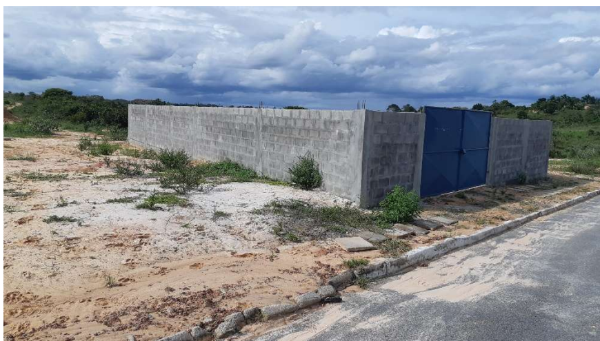
FOTO 08: ESTAÇÃO ELEVATÓRIA DE ESGOTO BRUTO.
