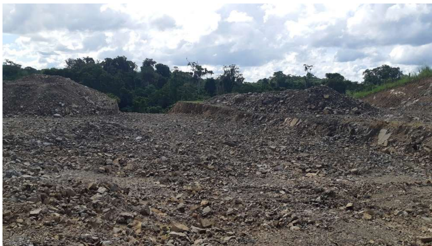
FOTO 01: ESCAVAÇÃO DE MATERIAL DA 2ª FASE – ETAPA 1.
