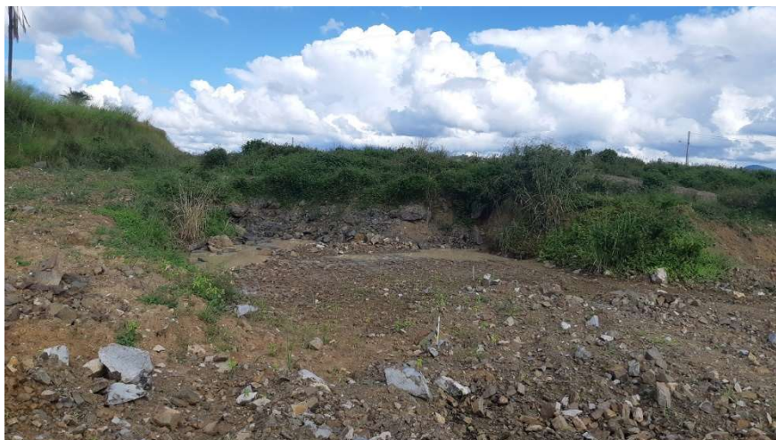
FOTO 05: TERRAPLANAGEM DA 2ª FASE – ETAPA 1.
