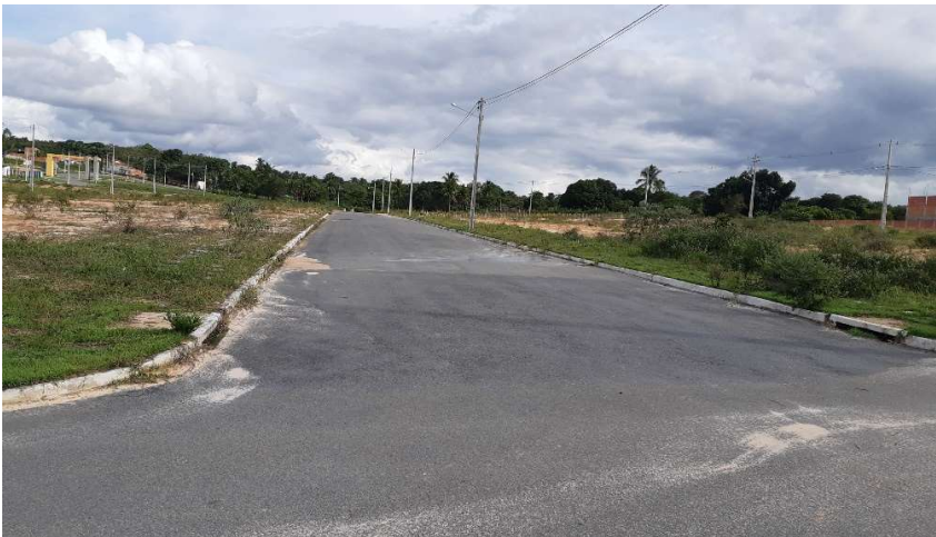
FOTO 41: RUA C3 –BOCAS DE LOBO.
