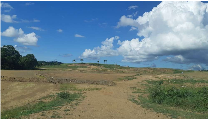
FOTO 15: TERRAPLANAGEM E LIMPEZA DA 2ª FASE – ETAPA 1.
