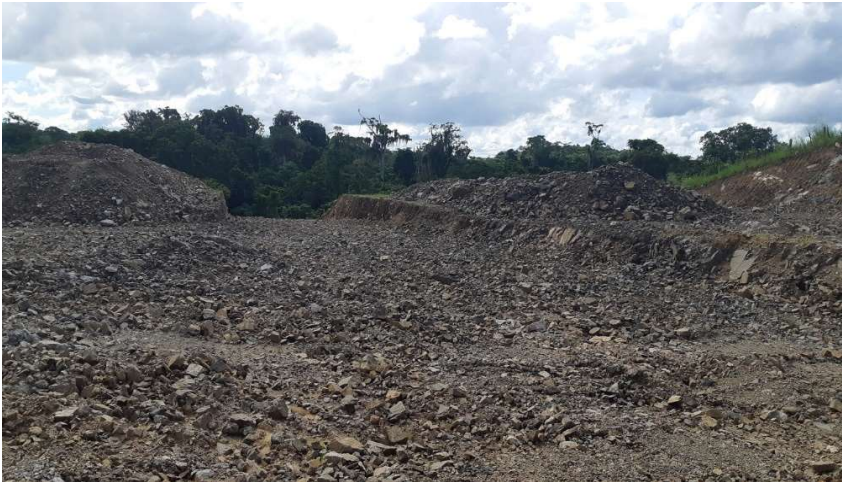
FOTO 01: ESCAVAÇÃO DE MATERIAL DA 2ª FASE – ETAPA 1.
