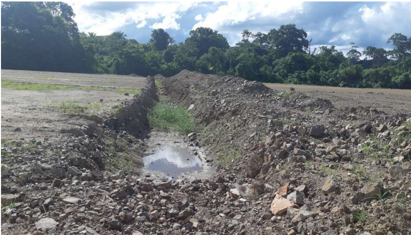
FOTO 16: ESCAVAÇÃO DE MATERIAL DA 2ª FASE – ETAPA 1.
