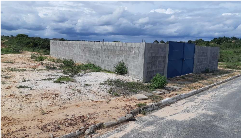
FOTO 08: ESTAÇÃO ELEVATÓRIA DE ESGOTO BRUTO.
