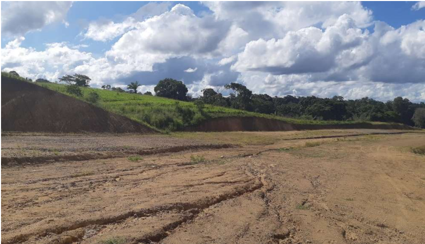
FOTO 13: TERRAPLANAGEM DA 2ª FASE – ETAPA 1.
