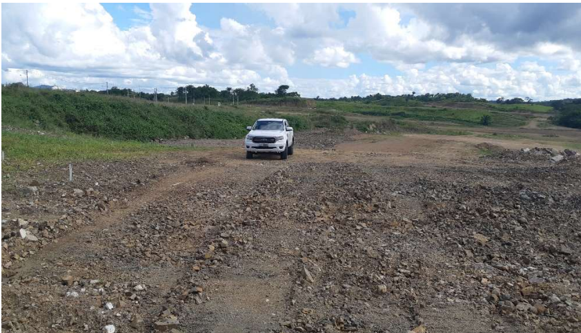
FOTO 17: TERRAPLANAGEM E LIMPEZA DA 2ª FASE – ETAPA 1.
