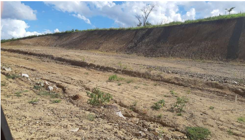
FOTO 14: TERRAPLANAGEM DA 2ª FASE – ETAPA 1.
