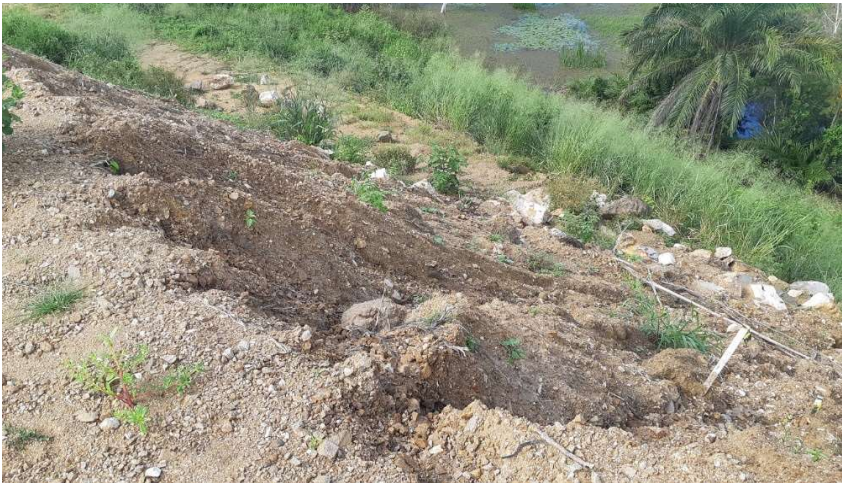
FOTO 07: ESCAVAÇÃO DE MATERIAL DA 2ª FASE – ETAPA 1.
