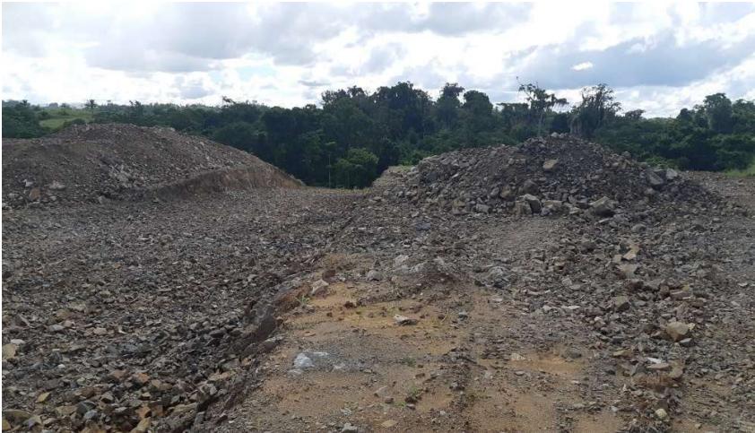
FOTO 02: ESCAVAÇÃO DE MATERIAL DA 2ª FASE – ETAPA 1
