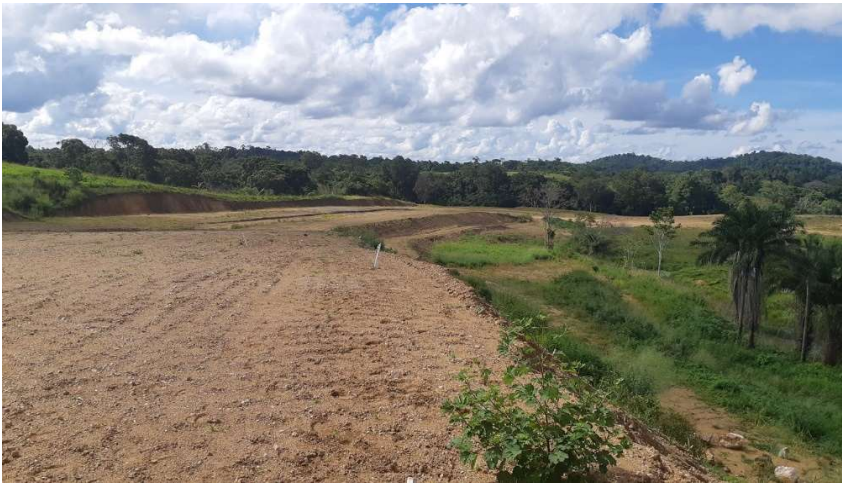
FOTO 12: TERRAPLANAGEM E LIMPEZA DA 2ª FASE – ETAPA 1.
