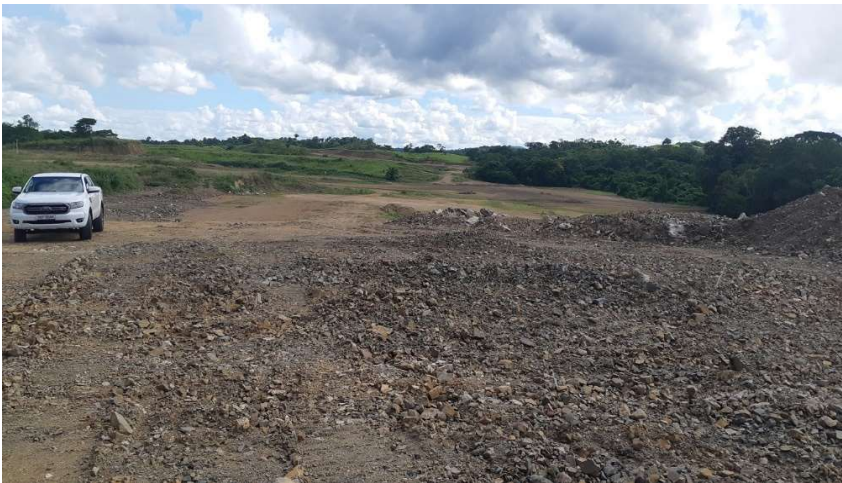
FOTO 03: TERRAPLANAGEM E ESCAVAÇÃO DA 2ª FASE – ETAPA 1..
