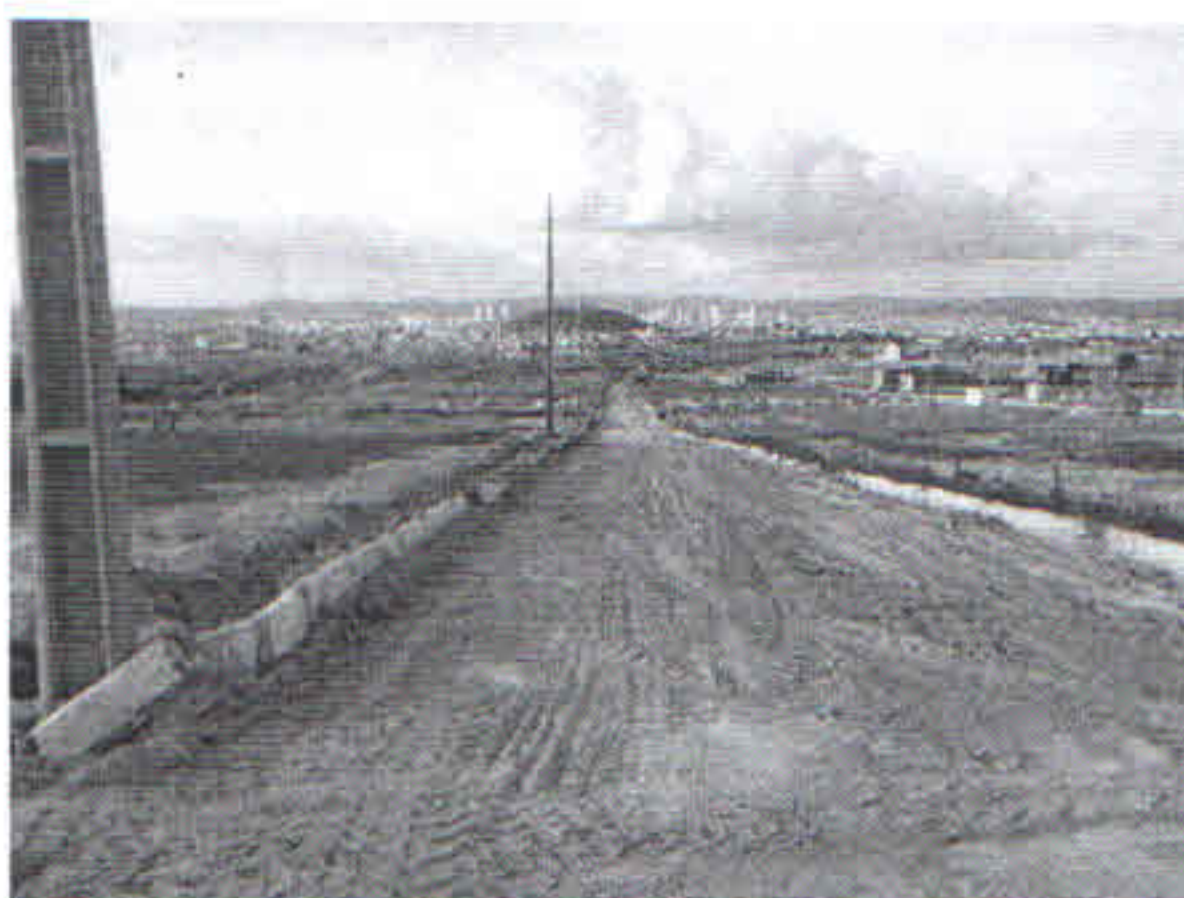
FOTO 09: RUA PROJETADA R-2, (ENTRE AS QUADRAS D e H), TERRAPLENAGEM, MEIO-FIO E POSTES ELÉTRICOS.
