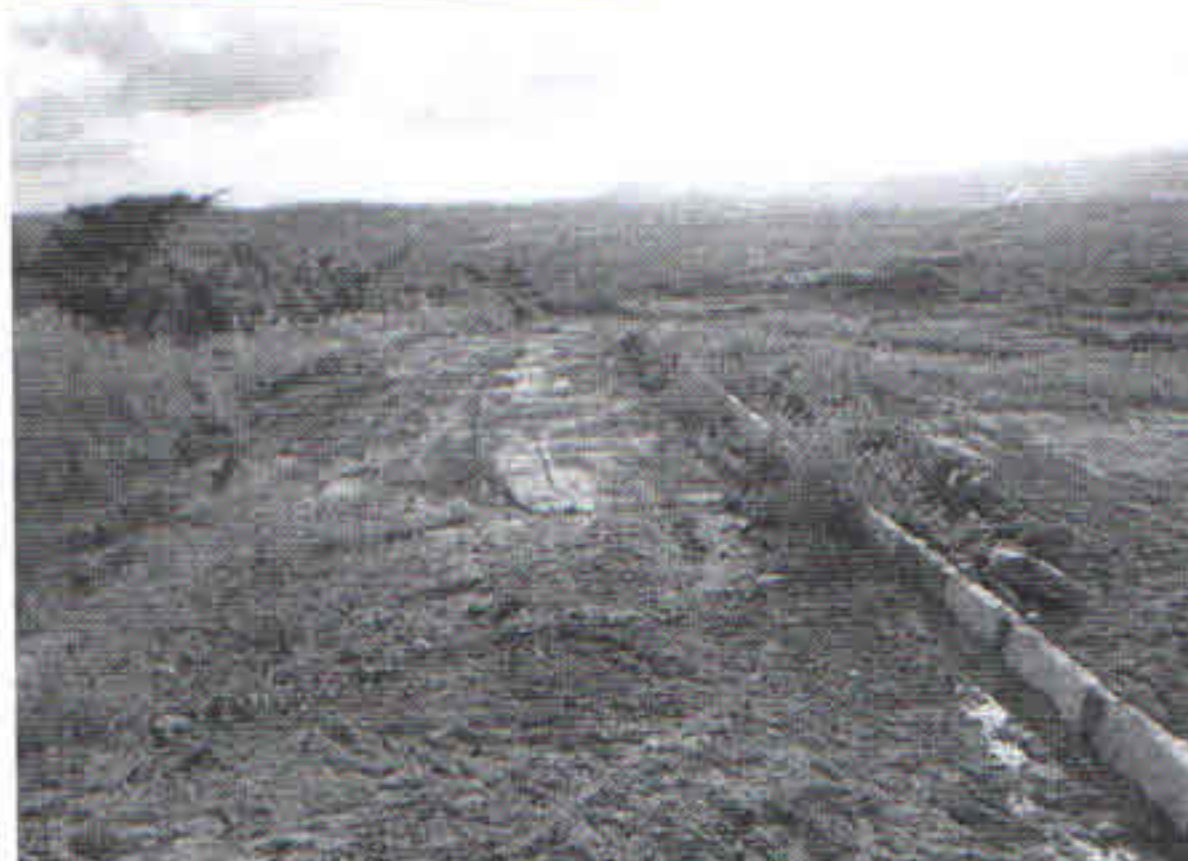
FOTO 19: RUA PROJETADA R-6 (ATRÁS DAS QUADRAS C e G )TERRAPLENAGEM E MEIO FIO.
