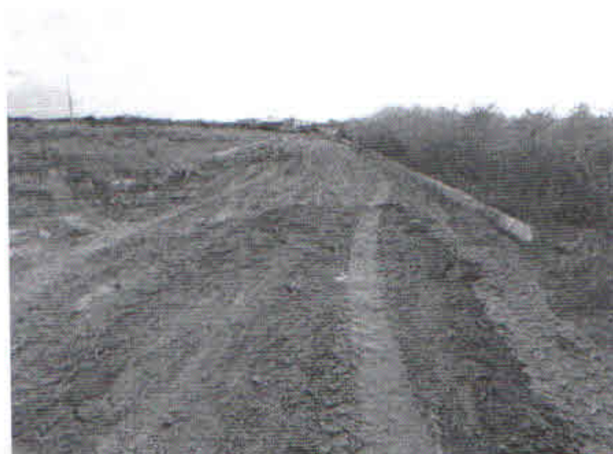
FOTO 14: RUA PROJETADA R-3, TERRAPLENAGEM E MEIO FIO.
