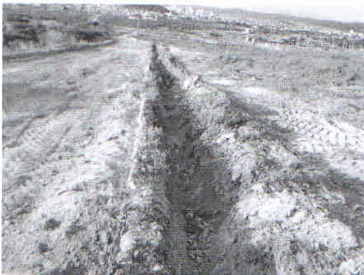
FOTO 02: RUA PROJETADA R-1 (AO LADO DA QUADRA C, ESCAVAÇÃO PARA REDE DE ESGOTO).
