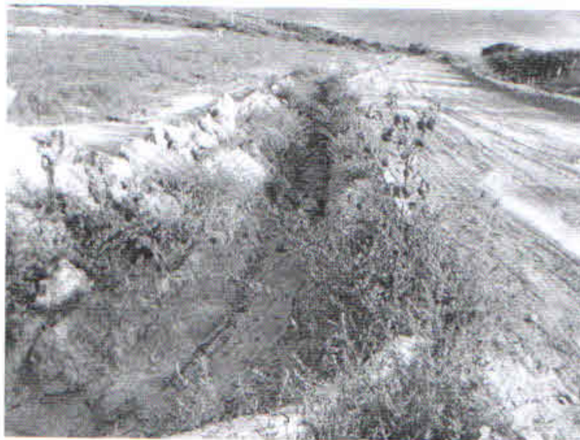
FOTO 18: RUA PROJETADA R-5, MEIO-FIO E ESCAVAÇÃO PARA REDE DE ESGOTO SANITÁRIO.
