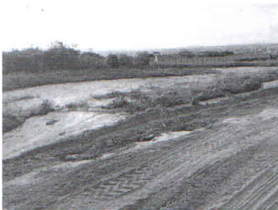
FOTO 06: RUA PROJETADA R-1 (AO LADO DA QUADRA A, ONDE O MEIO-FIO FOI ARRANCADO DEVIDO A ÁGUA PLUVIAL).
