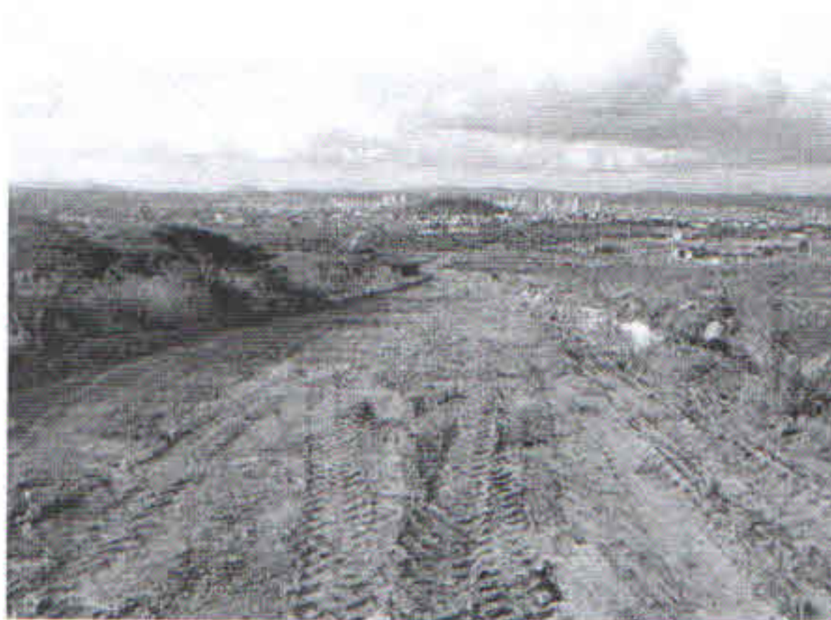
FOTO 01: RUA PROJETADA R-1 (AO LADO DA QUADRA C, TERRAPLENAGEM E EXECUÇÃO DO MEIO-FIO).
