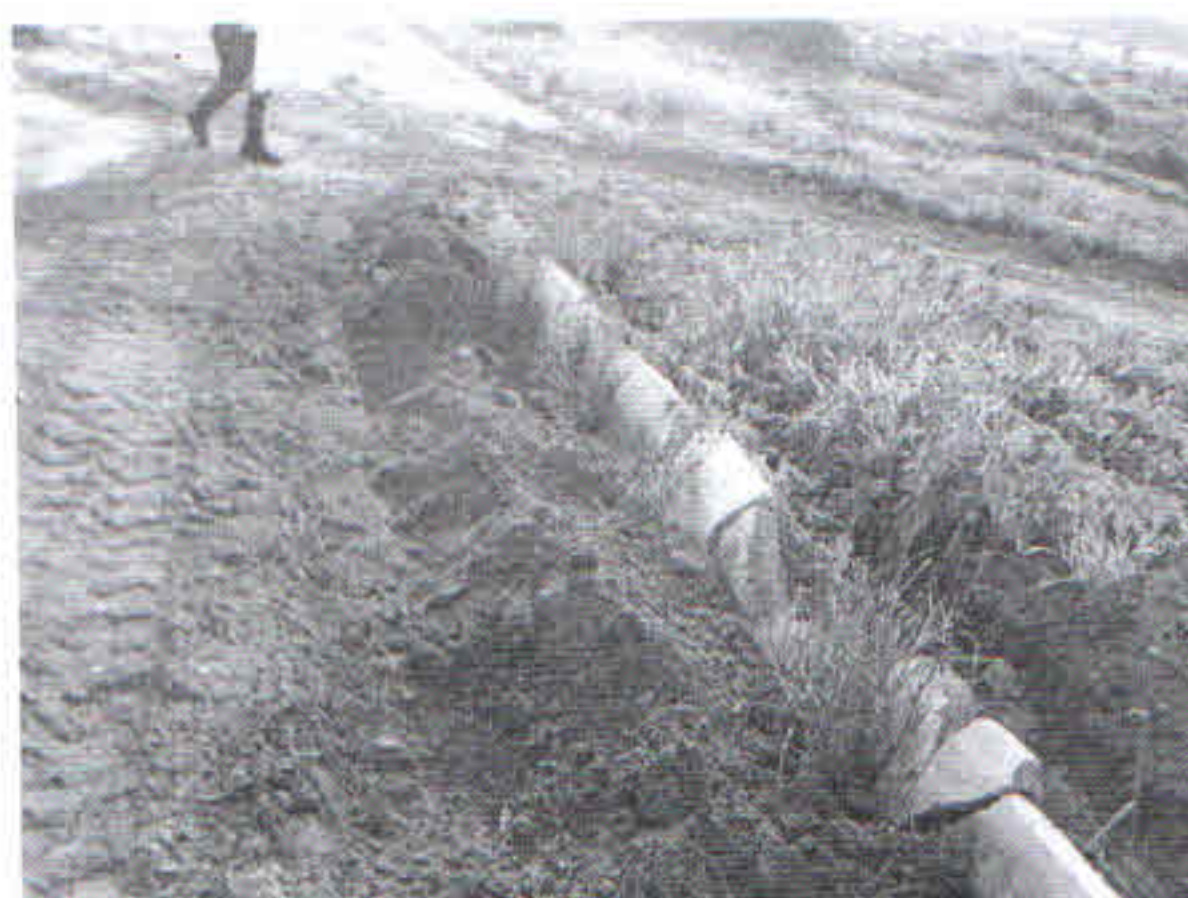
FOTO 21: RUA PROJETADA R-6 – TERRAPLENAGEM E MEIO FIO.
