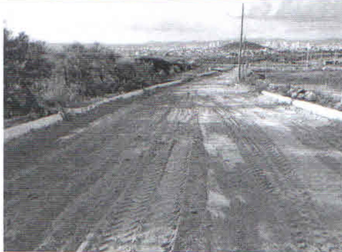
FOTO 04: RUA PROJETADA R-1 (AO LADO DA QUADRA D, EXECUÇÃO DE MEIO-FIO E POSTES ELÉTRICOS).
