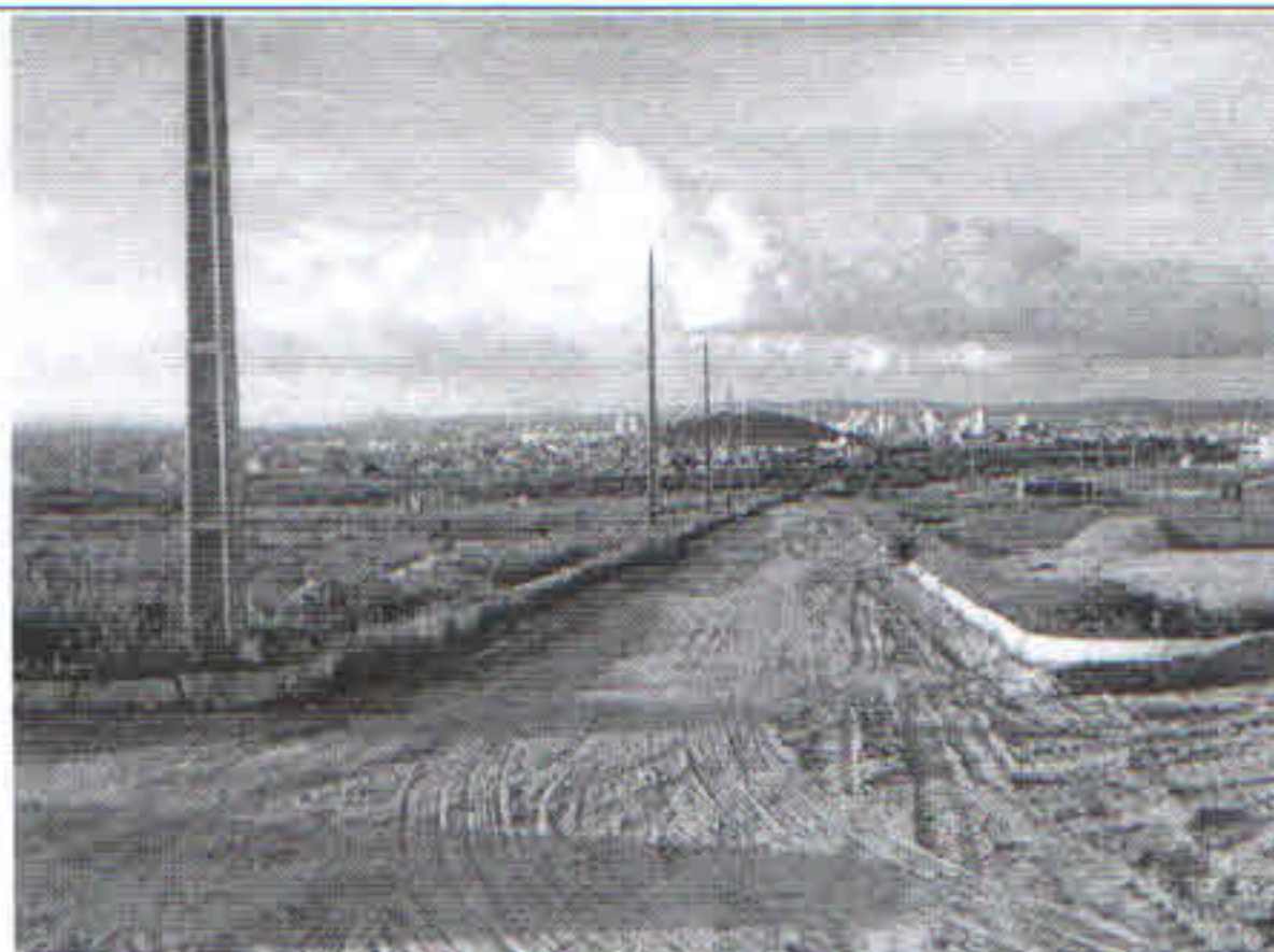
FOTO 10: RUA PROJETADA R-2 (ENTRE AS QUADRAS E e I ), TERRAPLENAGEM, MEIO-FIO E POSTES ELÉTRICOS.
