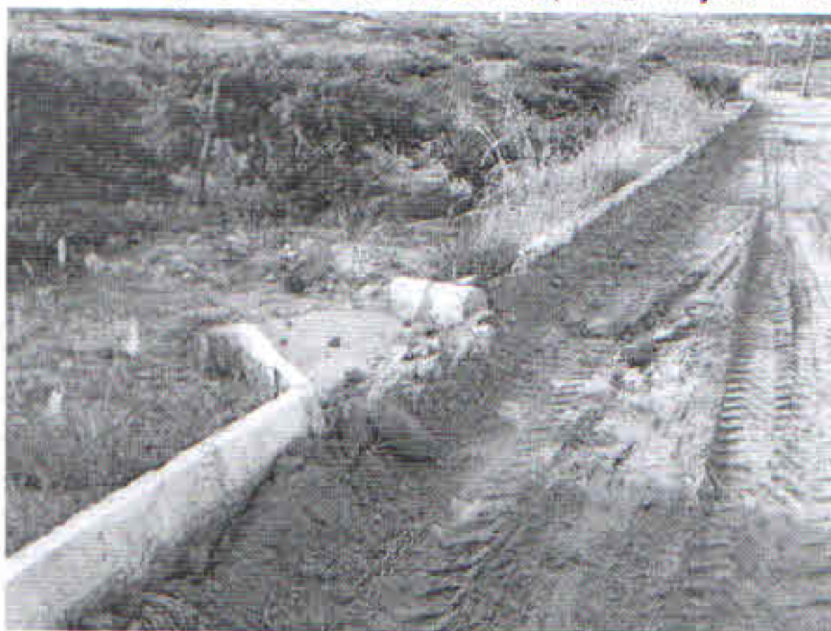
FOTO 03: RUA PROJETADA R-1 (AO LADO DA QUADRA C, EXECUÇÃO DA DRENAGEM SUPERFICIAL DE ÁGUA PLUVIAL).
