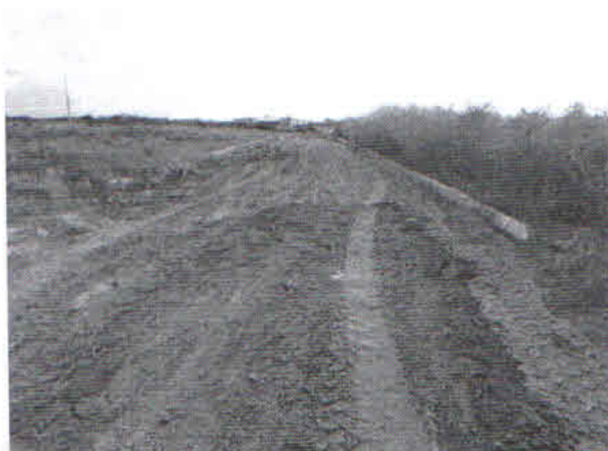
FOTO 14: RUA PROJETADA R-3, TERRAPLENAGEM E MEIO FIO.
