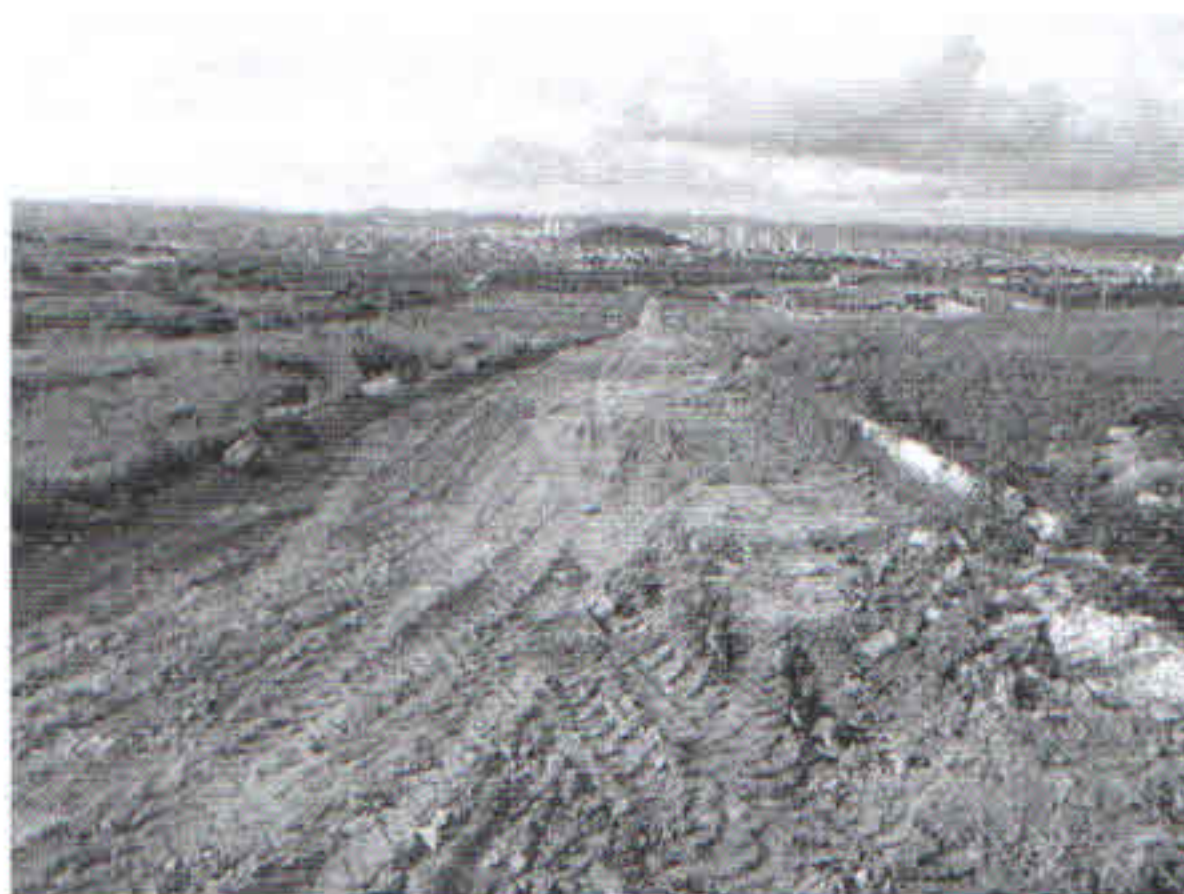
FOTO 08: RUA PROJETADA R-2, (ENTRE AS QUADRAS C e G), TERRAPLENAGEM E MEIO-FIO.
