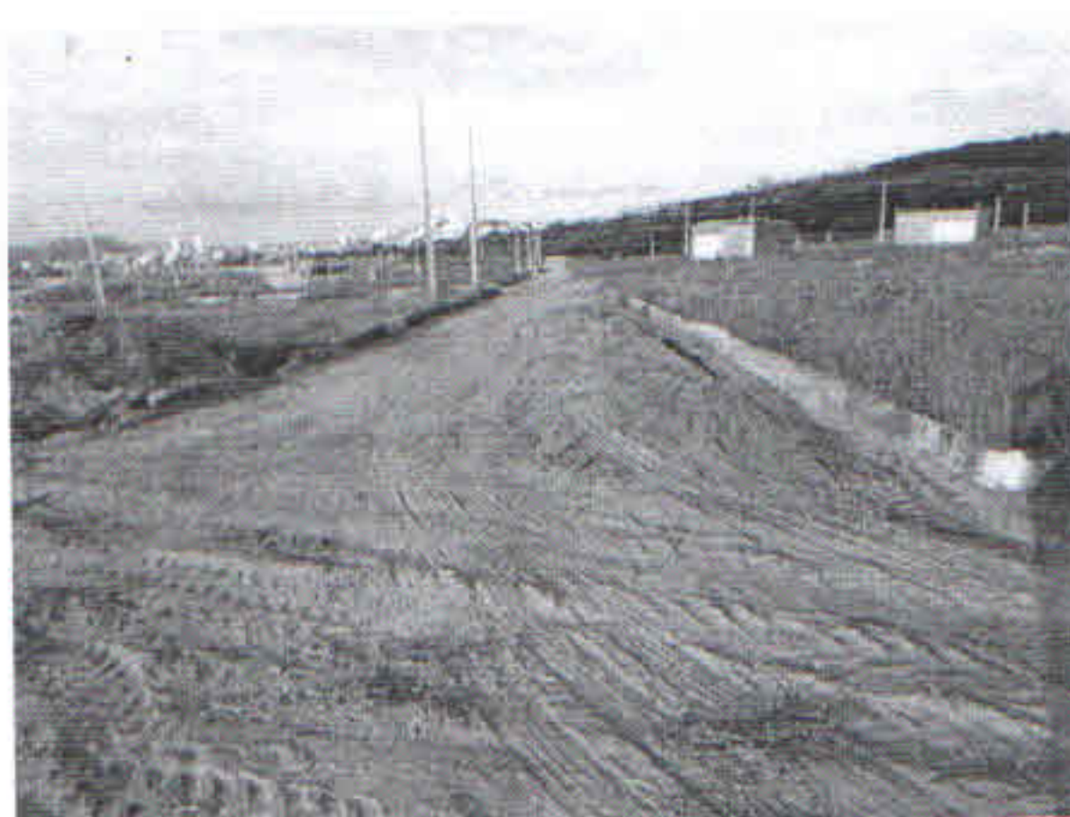
FOTO 15: RUA PROJETADA R-4 (ENTRE AS QUADRAS I e J) – TERRAPLENAGEM, MEIO-FIO E POSTES ELÉTRICOS.
