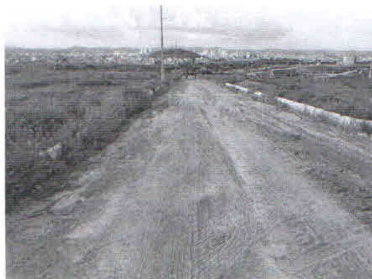
FOTO 11: RUA PROJETADA R-2, (ENTRE AS QUADRAS F e J ) – TERRAPLENAGEM, MEIO-FIO E POSTES ELÉTRICOS.
