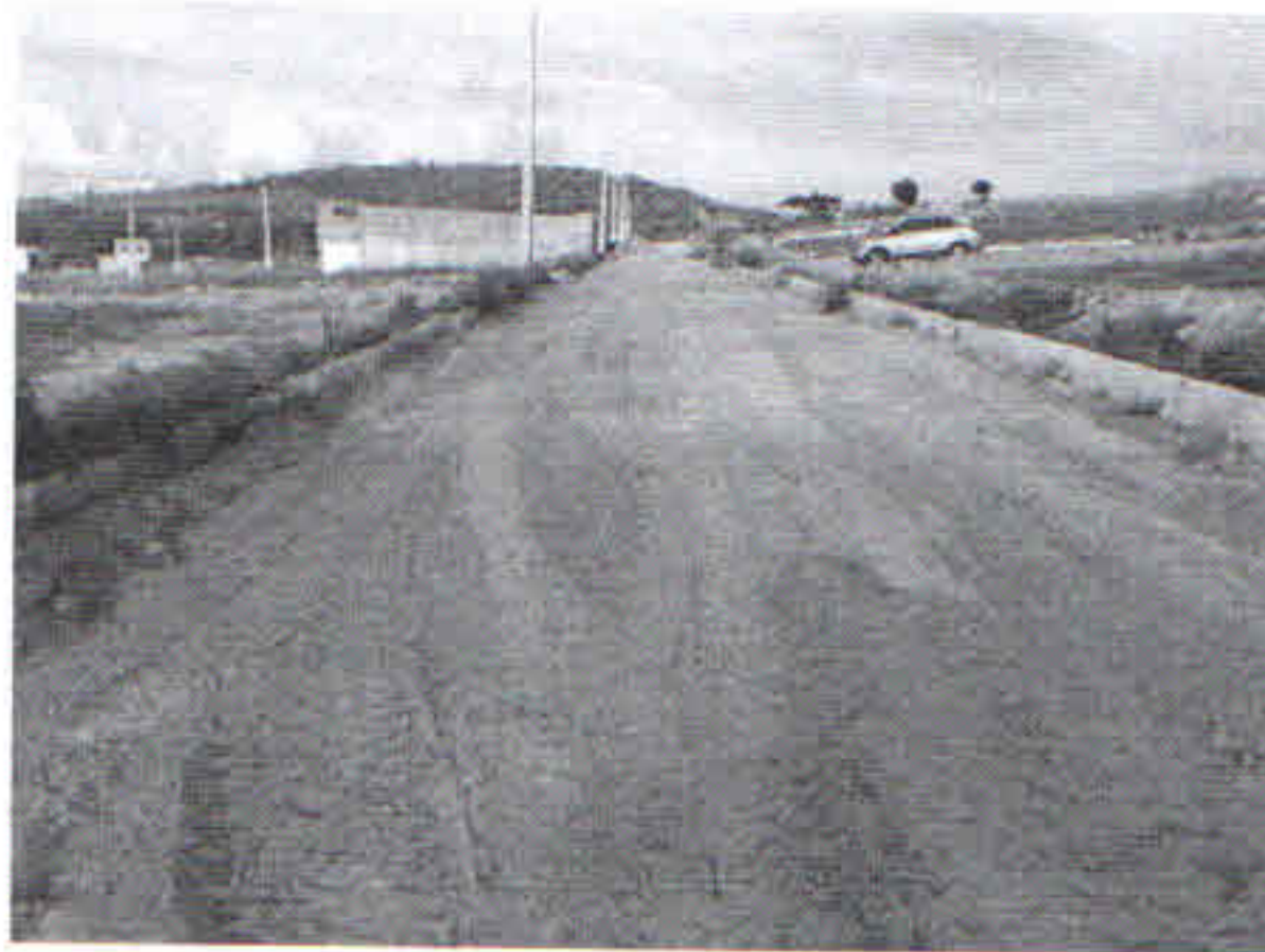
FOTO 17: RUA PROJETADA R-5 – TERRAPLENAGEM, MEIO-FIO E POSTES ELÉTRICOS.
