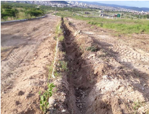
FOTO 02: RUA PROJETADA R-1 (AO LADO DA QUADRA C, ESCAVAÇÃO PARA REDE DE ESGOTO).
