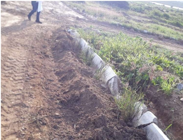
FOTO 21: RUA PROJETADA R-6 – TERRAPLENAGEM E MEIO FIO.
