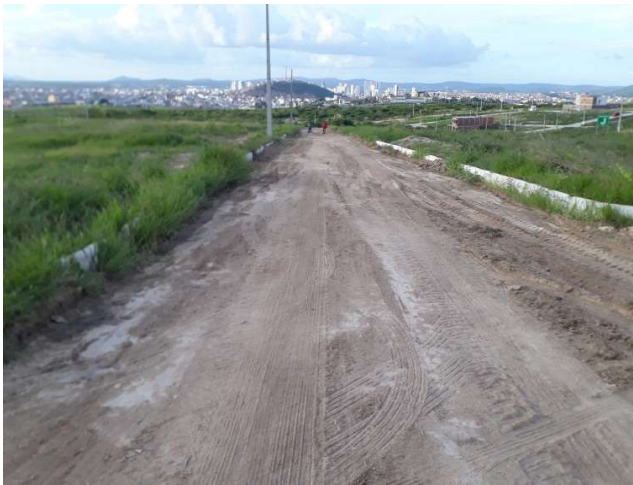
FOTO 11: RUA PROJETADA R-2, (ENTRE AS QUADRAS F e J ) – TERRAPLENAGEM, MEIO-FIO E POSTES ELÉTRICOS.
