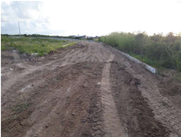
FOTO 14: RUA PROJETADA R-3 , TERRAPLENAGEM E MEIO FIO.
