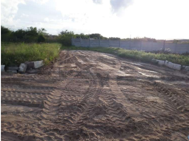
FOTO 16: : RUA PROJETADA R- 4 (ENTRE AS QUADRAS E e F) – TERRAPLENAGEM E MEIO-FIO.
