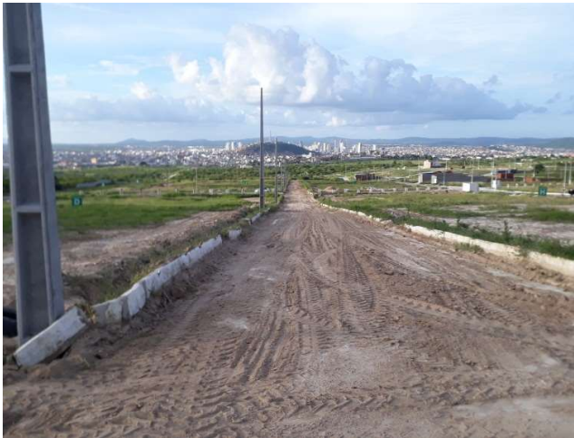
FOTO 09: RUA PROJETADA R-2, (ENTRE AS QUADRAS D e H), TERRAPLENAGEM, MEIO-FIO E POSTES ELÉTRICOS.
