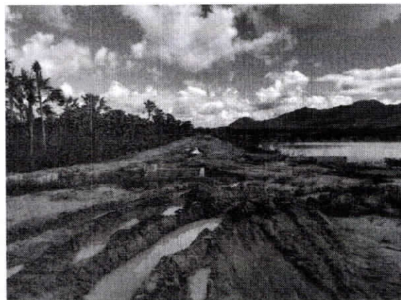
FOTO 04: AVENIDA DAS JARDINEIRAS
