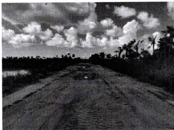
FOTO 03: AVENIDA DAS JARDINEIRAS
