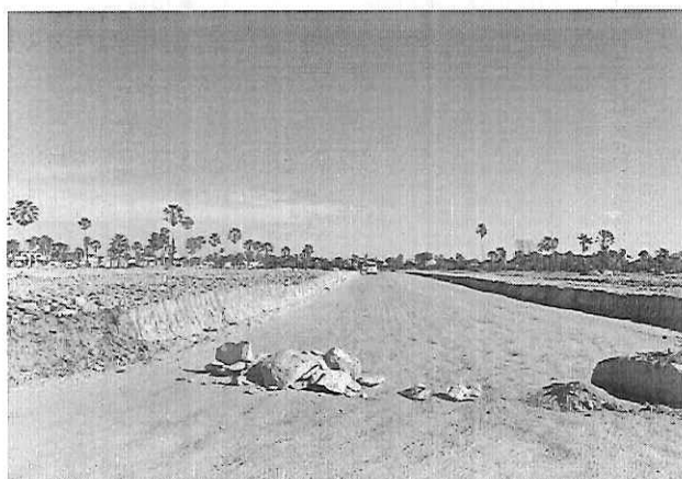
FOTO 41: TERRAPLANAGEM – FOTO DE FEVEREIRO
