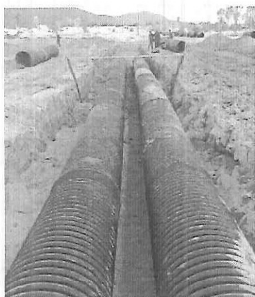
FOTO 39: ASSENTAMENTO DE TUBO DE DRENAGEM – FOTO DE FEVEREIRO
