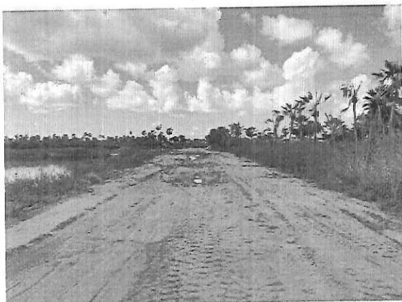
FOTO 03: AVENIDA DAS JARDINEIRAS
