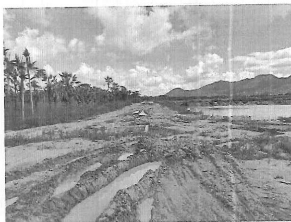
FOTO 04: AVENIDA DAS JARDINEIRAS
