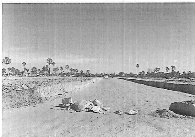
FOTO 41: TERRAPLANAGEM – FOTO DE FEVEREIRO
