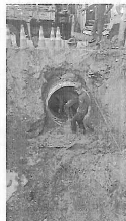
FOTO 42: TRAVESSIA DA REDE DE DRENAGEM – FOTO DE FEVEREIRO
