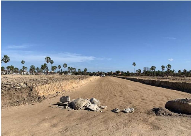
FOTO 41: TERRAPLANAGEM – FOTO DE FEVEREIRO
