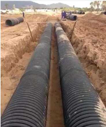
FOTO 39: ASSENTAMENTO DE TUBO DE DRENAGEM – FOTO DE FEVEREIRO
