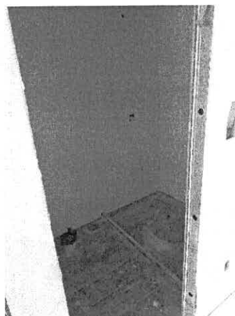
Banheiro subtelhado Bloco D
