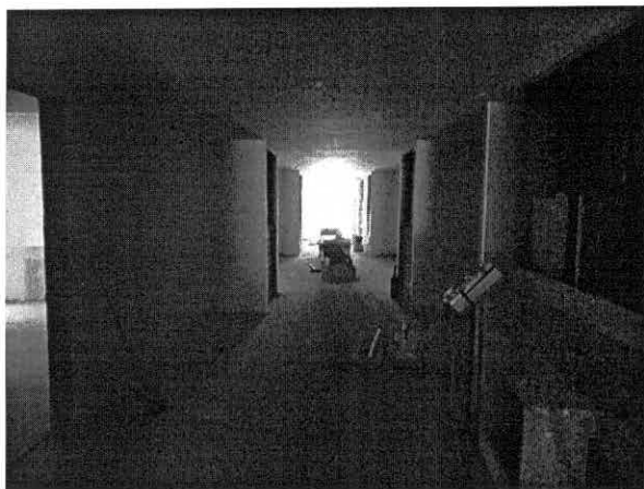
Circulação subtelhado Bloco D
