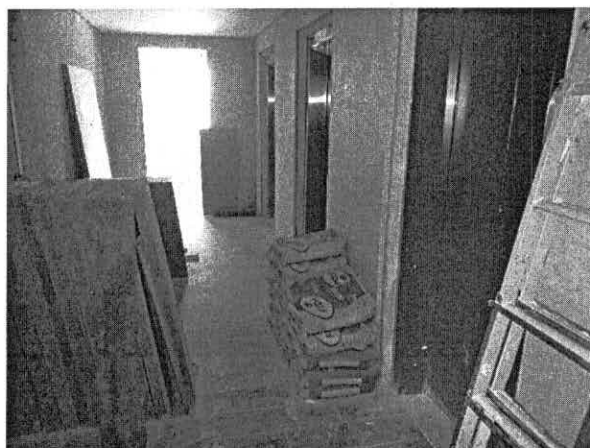
Frente elevadores subtelhado Bloco D
