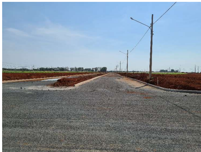
FOTO 01: AV. TANCREDO NEVES COM MEIO FIOS EXECUTADOS.
