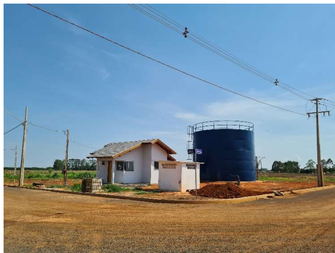
FOTO 20: CENTRO DE RESERVAÇÃO DE ÁGUA.
