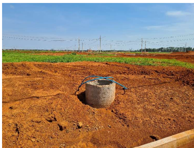
FOTO 18: AV. LEONEL, DETALHE POÇO DE VISITA DE ESGOTO.
