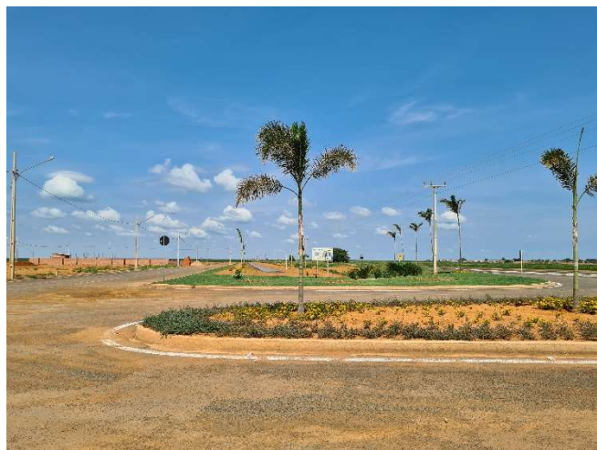
FOTO 23: TREVO DE ACESSO AO EMPREENDIMENTO.
