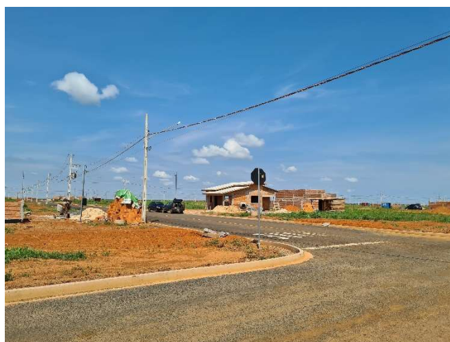
FOTO 21: CASAS SENDO CONSTRUÍDAS PELO LOTEAMENTO.
