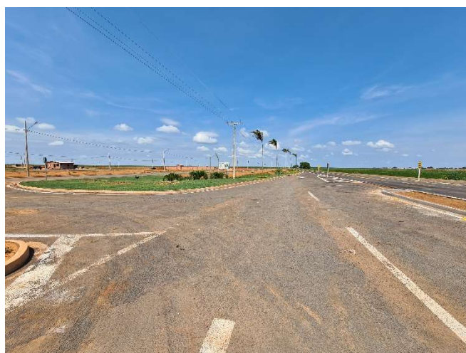
FOTO 24: TREVO DE ACESSO AO EMPREENDIMENTO.
