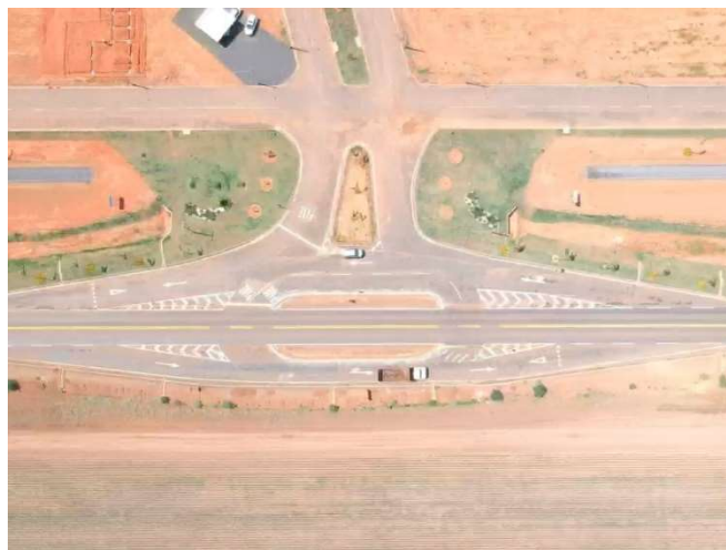
FOTO 25: TREVO DE ACESSO AO EMPREENDIMENTO.
