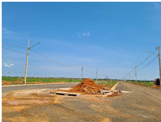
FOTO 22: AVENIDA A – BOCAS DE LOBO EXECUTADAS.
