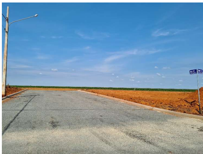
FOTO 15: RUA 07 COM MEIO FIOS, REDES DE ÁGUA E ESGOTO EXECUTADOS.
