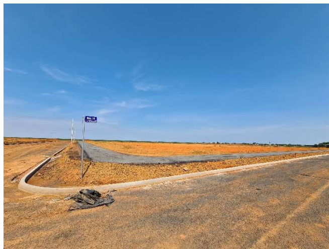
FOTO 07: CALÇADA DA BACIA DE CONTENÇÃO EXECUTADA.
