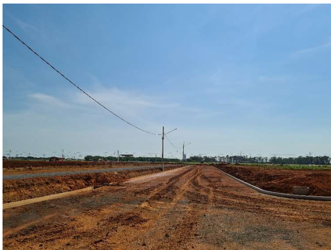
FOTO 05: RUA 2-A COM MEIO FIOS, REDES DE ÁGUA E ESGOTO EXECUTADOS.
