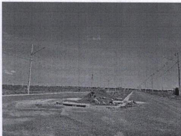
FOTO 22: AVENIDA A – BOCAS DE LOBO EXECUTADAS.
