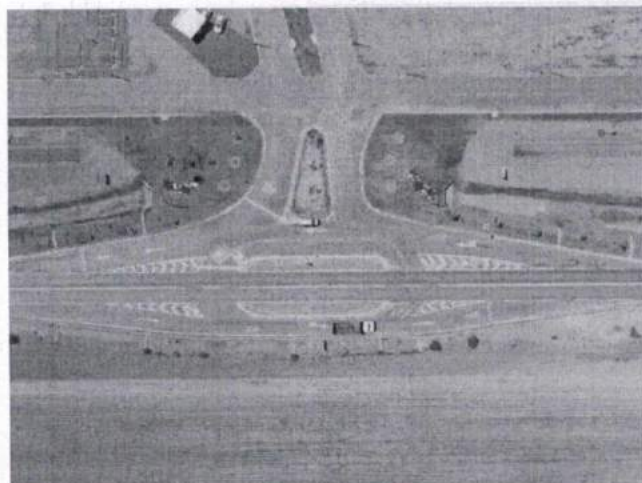
FOTO 25: TREVO DE ACESSO AO EMPREENDIMENTO.
