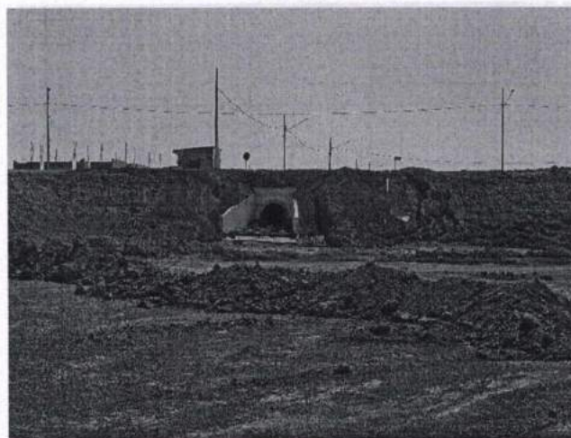
FOTO 08: BOCAS DE BUEIRO COM DISSIPADORES DE ENERGIA EXECUTADOS NA BACIA.
