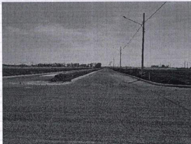
FOTO 01: AV. TANCREDO NEVES COM MEIO FIOS EXECUTADOS.
