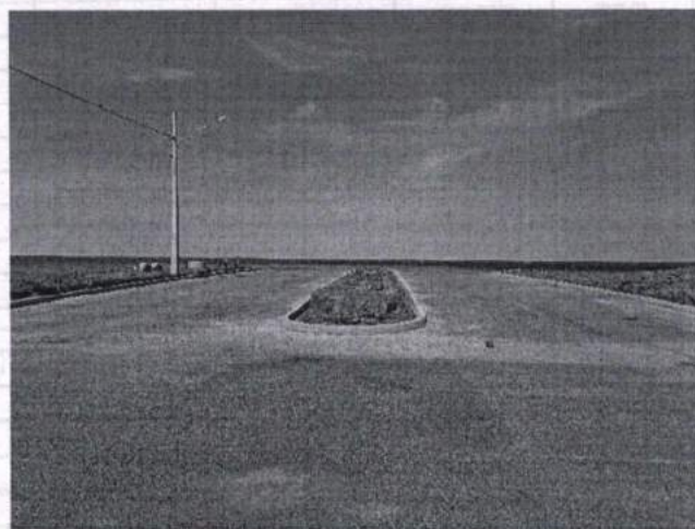
FOTO 02: AV. TANCREDO NEVES COM MEIO FIOS EXECUTADOS.
