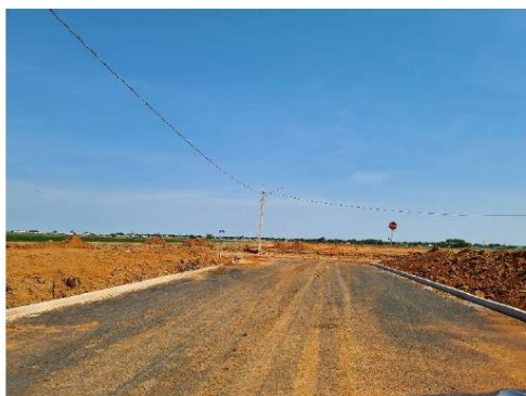
FOTO 04: RUA 16 COM MEIO FIOS, REDES DE ÁGUA E ESGOTO EXECUTADOS.
