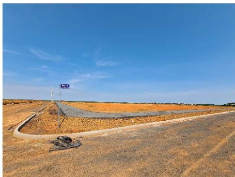
FOTO 07: CALÇADA DA BACIA DE CONTENÇÃO EXECUTADA.
