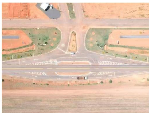
FOTO 25: TREVO DE ACESSO AO EMPREENDIMENTO.
