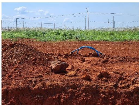
FOTO 11: RUA 05 COM REDES DE ÁGUA E ESGOTO EXECUTADOS.
