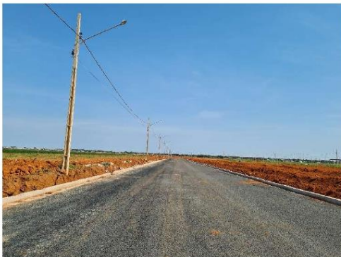
FOTO 03: RUA 16 COM MEIO FIOS, REDES DE ÁGUA E ESGOTO EXECUTADOS.
