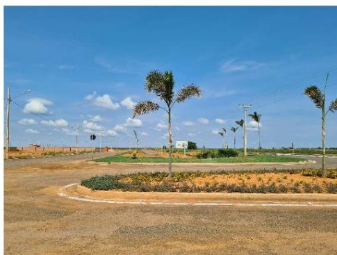
FOTO 23: TREVO DE ACESSO AO EMPREENDIMENTO.
