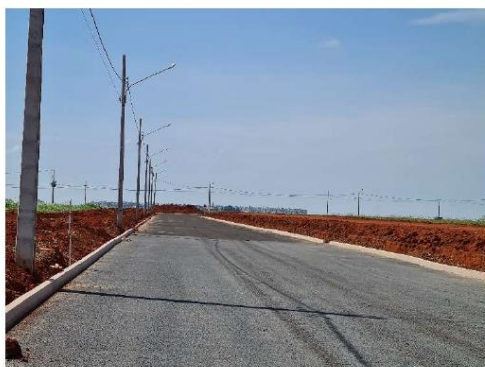
FOTO 14: RUA 18 COM MEIO FIOS, REDES DE ÁGUA E ESGOTO EXECUTADOS.
