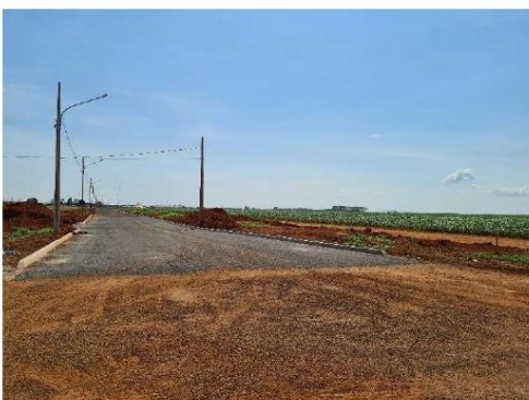
FOTO 17: AV. LEONEL COM MEIO FIOS, REDES DE ÁGUA E ESGOTO EXECUTADOS.
