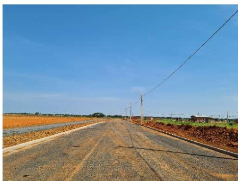
FOTO 06: RUA 14 COM MEIO FIOS, REDES DE ÁGUA E ESGOTO EXECUTADOS.
