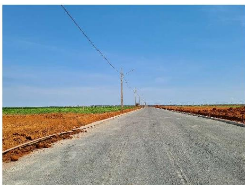
FOTO 16: AVENIDA LEONEL COM MEIO FIOS, REDES DE ÁGUA E ESGOTO EXECUTADOS.
