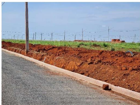
FOTO 13: RUA 19 COM MEIO FIOS, REDES DE ÁGUA E ESGOTO EXECUTADOS.
