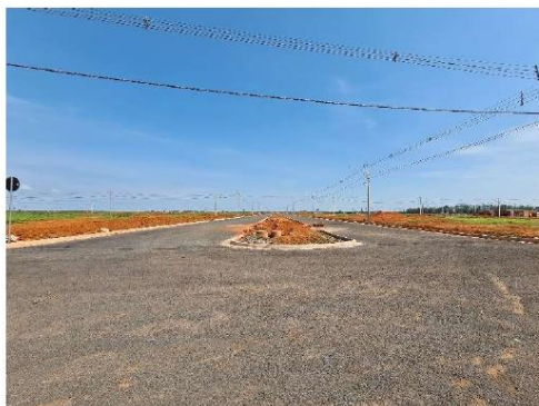
FOTO 19: AV. A COM MEIO FIOS NAS LATERAIS E CANTEIRO CENTRAL EXECUTADOS.
