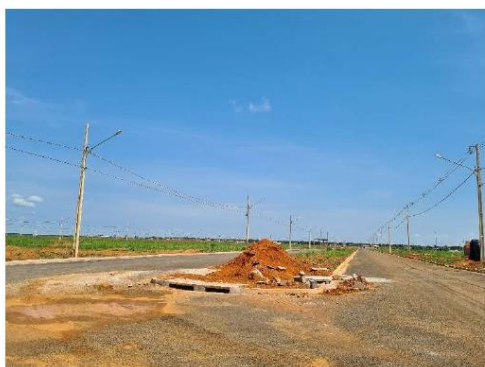
FOTO 22: AVENIDA A – BOCAS DE LOBO EXECUTADAS.
