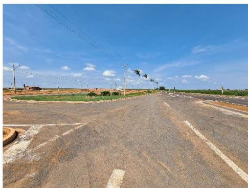
FOTO 24: TREVO DE ACESSO AO EMPREENDIMENTO.
