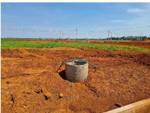
FOTO 18: AV. LEONEL, DETALHE POÇO DE VISITA DE ESGOTO.
