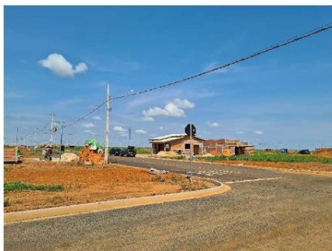
FOTO 21: CASAS SENDO CONSTRUÍDAS PELO LOTEAMENTO.
