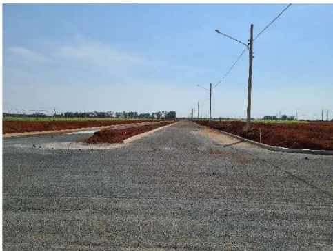
FOTO 01: AV. TANCREDO NEVES COM MEIO FIOS EXECUTADOS.
