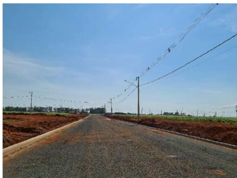
FOTO 10: RUA 04 COM MEIO FIOS, REDES DE ÁGUA E ESGOTO EXECUTADOS.
