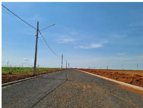
FOTO 09: RUA 15 COM MEIO FIOS, REDES DE ÁGUA E ESGOTO EXECUTADOS.
