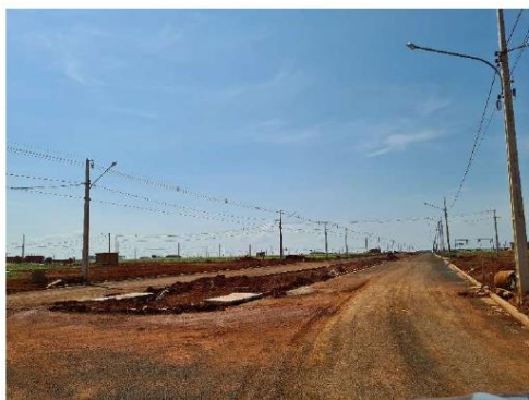
FOTO 12: AVENIDA A COM MEIO FIOS, REDES DE ÁGUA E ESGOTO EXECUTADOS.
