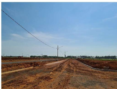
FOTO 05: RUA 2-A COM MEIO FIOS, REDES DE ÁGUA E ESGOTO EXECUTADOS.
