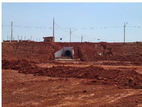
FOTO 08: BOCAS DE BUEIRO COM DISSIPADORES DE ENERGIA EXECUTADOS NA BACIA.
