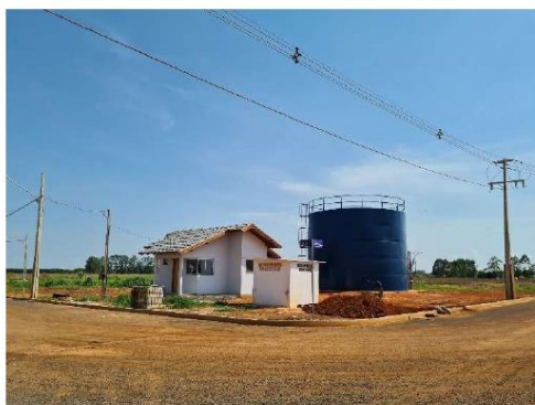
FOTO 20: CENTRO DE RESERVAÇÃO DE ÁGUA.
