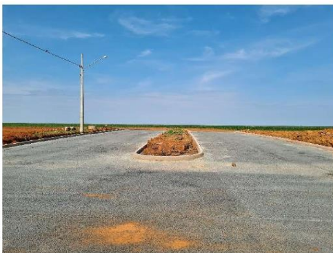
FOTO 02: AV. TANCREDO NEVES COM MEIO FIOS EXECUTADOS.
