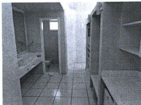
FOTO 10: UNIDADE 1609 – BANGALÔ A REFORMAR.
