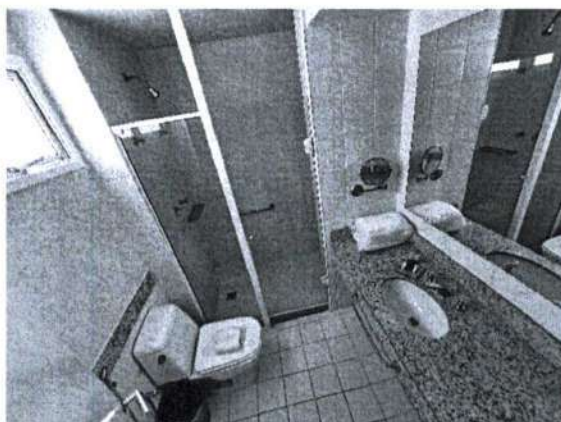
FOTO 26: UNIDADE 1512 – DOUBLE A REFORMAR.
