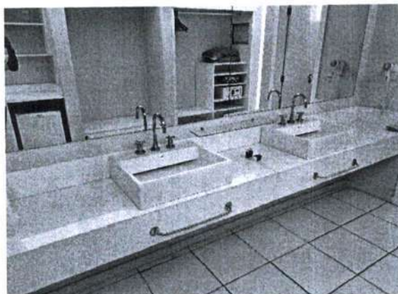
FOTO 11: UNIDADE 1609 – BANGALÔ A REFORMAR.
