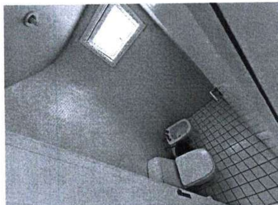
FOTO 12: UNIDADE 1609 – BANGALÔ A REFORMAR.
