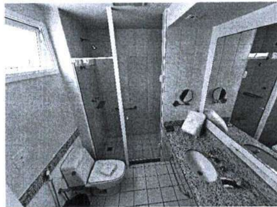
FOTO 22: UNIDADE 1550 – DOBLE A REFORMAR.
