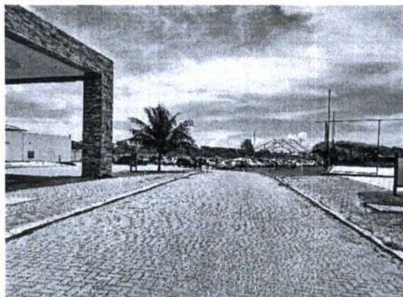
FOTO 01: PORTARIA E ESTACIONAMENTO.
