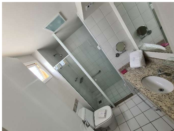
FOTO 20: UNIDADE 1550 – DOUBLE A REFORMAR.
