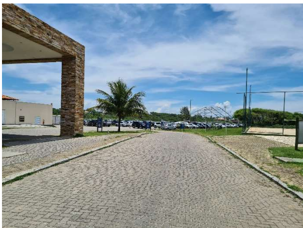
FOTO 01: PORTARIA E ESTACIONAMENTO.
