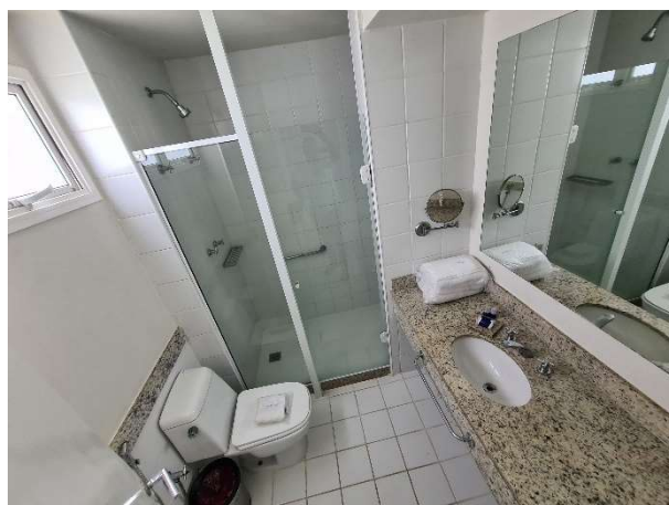
FOTO 26: UNIDADE 1512 – DOUBLE A REFORMAR.
