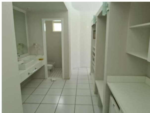
FOTO 10: UNIDADE 1609 – BANGALÔ A REFORMAR.
