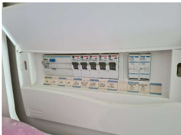
FOTO 21: UNIDADE 1550 – DOUBLE A REFORMAR.
