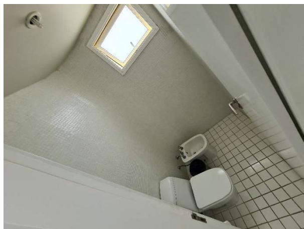
FOTO 12: UNIDADE 1609 – BANGALÔ A REFORMAR.
