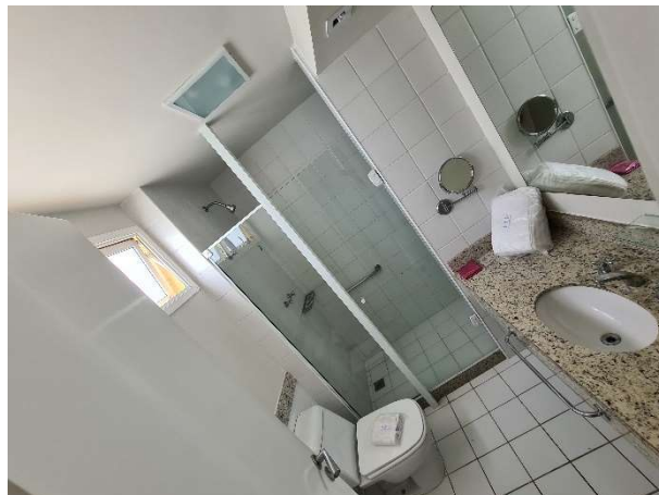
FOTO 20: UNIDADE 1550 – DOUBLE A REFORMAR.
