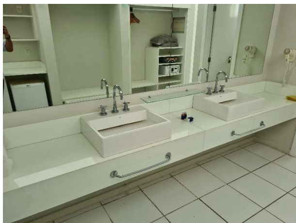
FOTO 11: UNIDADE 1609 – BANGALÔ A REFORMAR.
