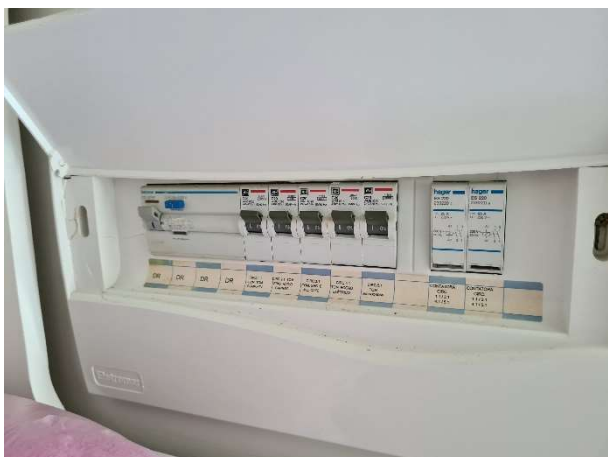
FOTO 21: UNIDADE 1550 – DOUBLE A REFORMAR.
