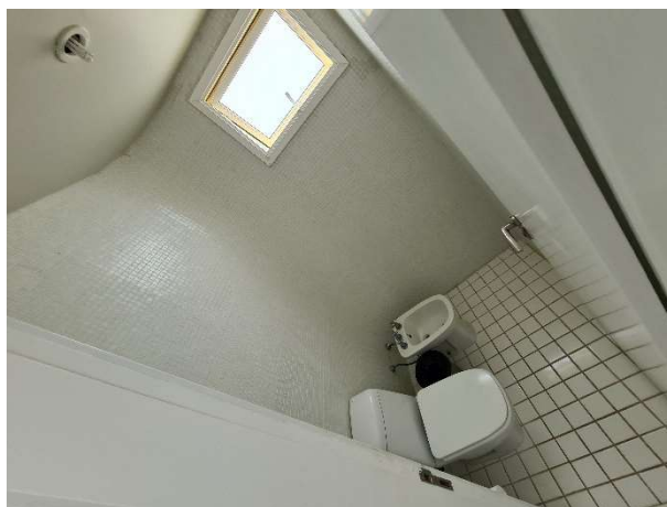
FOTO 12: UNIDADE 1609 – BANGALÔ A REFORMAR.
