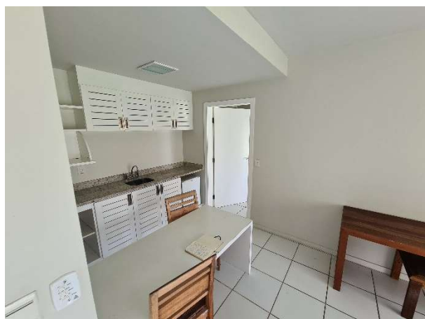
FOTO 18: UNIDADE 1550 –A SER REFORMADA.
