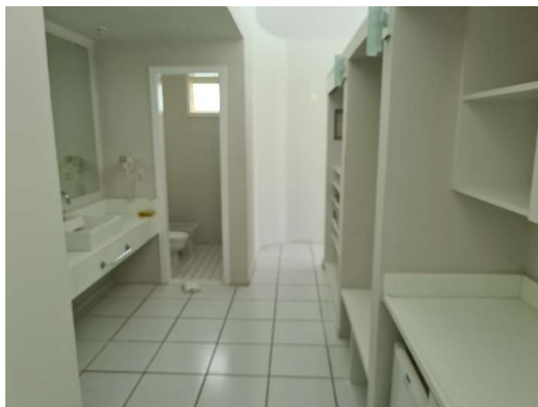
FOTO 10: UNIDADE 1609 – BANGALÔ A REFORMAR.
