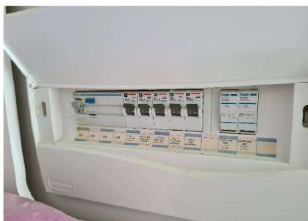
FOTO 21: UNIDADE 1550 – DOUBLE A REFORMAR.
