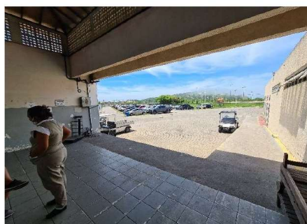
FOTO 46: DOCAS PARA ENTRADA DE INSUMOS.
