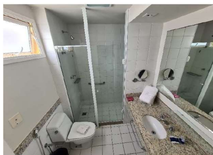
FOTO 22: UNIDADE 1550 – DOUBLE A REFORMAR.
