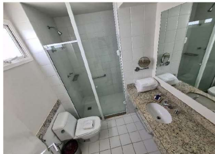
FOTO 26: UNIDADE 1512 – DOUBLE A REFORMAR.
