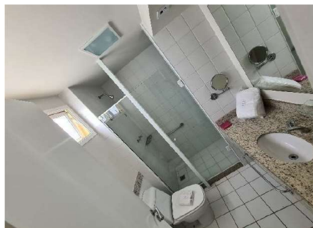
FOTO 20: UNIDADE 1550 – DOUBLE A REFORMAR.
