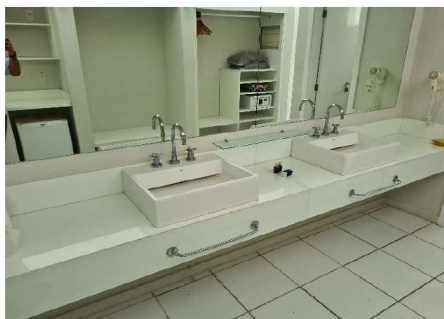
FOTO 11: UNIDADE 1609 – BANGALÔ A REFORMAR.
