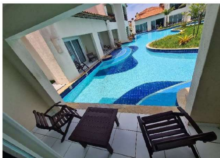
FOTO 27: UNIDADE 1512 – DOUBLE A REFORMAR.
