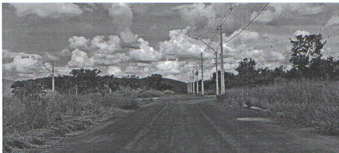
FOTO 02: QUADRAS NECESSITANDO ROÇADA.
