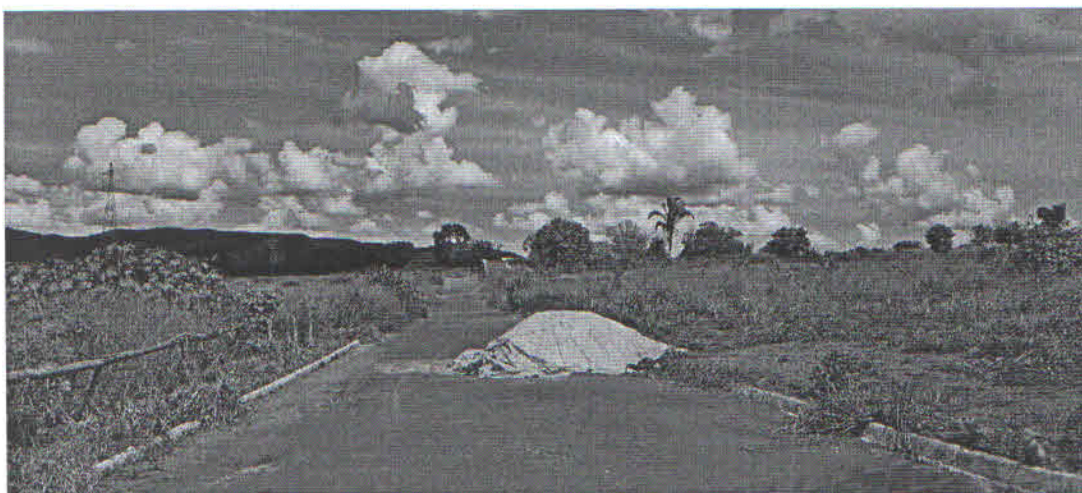
FOTO 12: MATERIAL ESTOCADO INCORRETAMENTE NA RUA.
