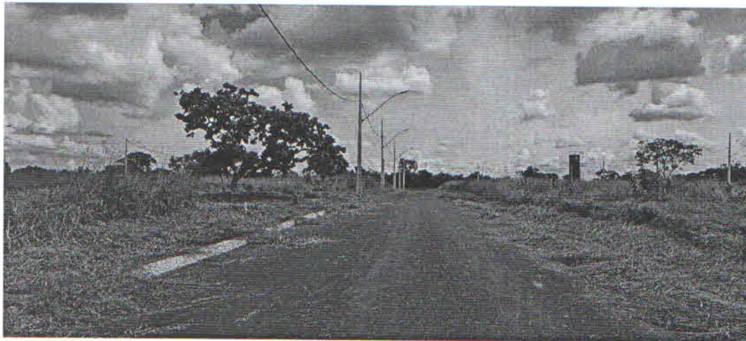
FOTO 05: RUA AFONSO RODRIGUES COM ROÇADA SENDO EXECUTADA.
