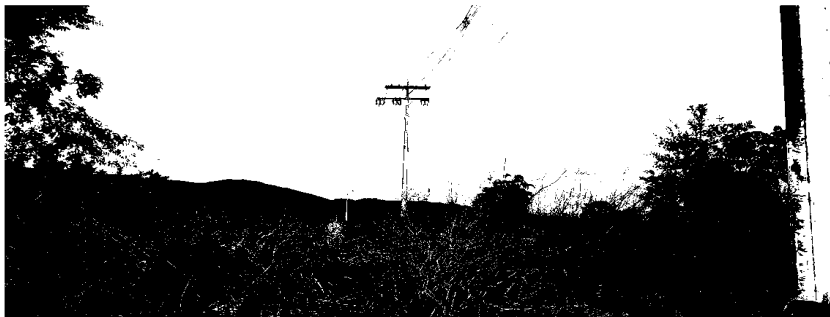
FOTO 07: RAMAL ALIMENTADOR DE ENTRADA DA REDE DE ENERGIA PRESERVADO.
