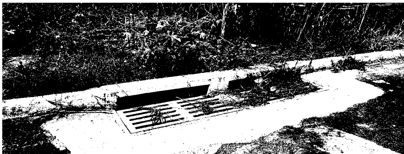
FOTO 13: FALTA LIMPEZA DAS BOCAS DE LOBO.
