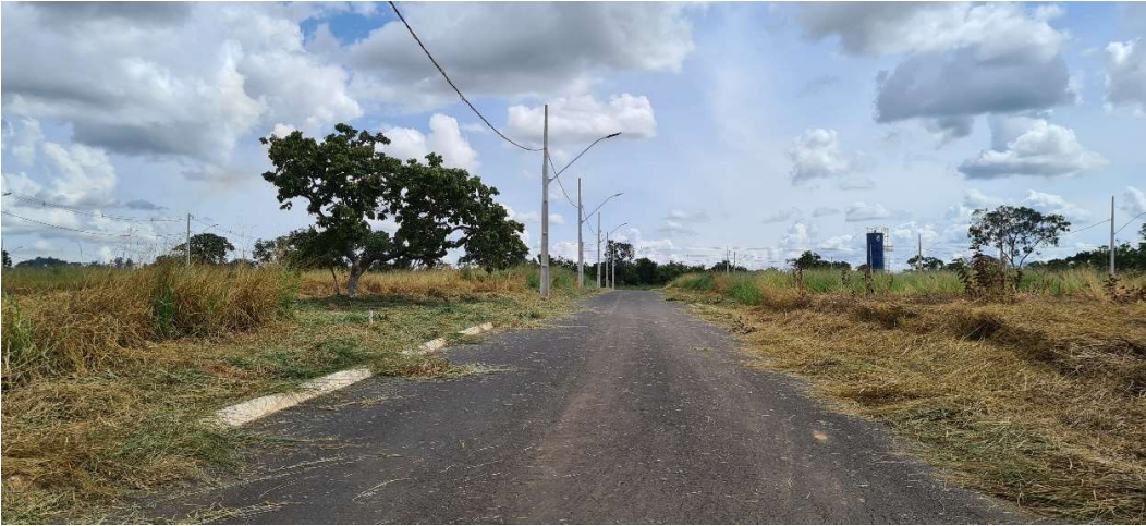
FOTO 05: RUA AFONSO RODRIGUES COM ROÇADA SENDO EXECUTADA.
