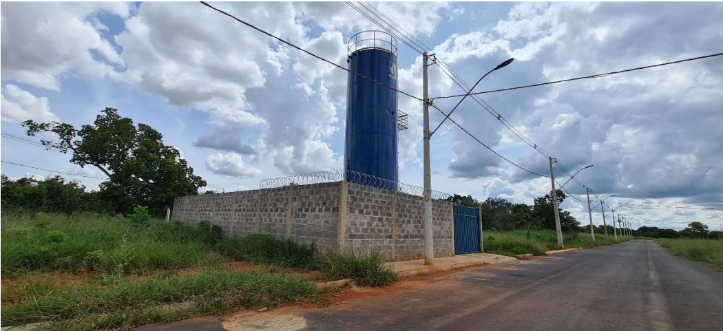
FOTO 01: CENTRO DE RESERVAÇÃO.
