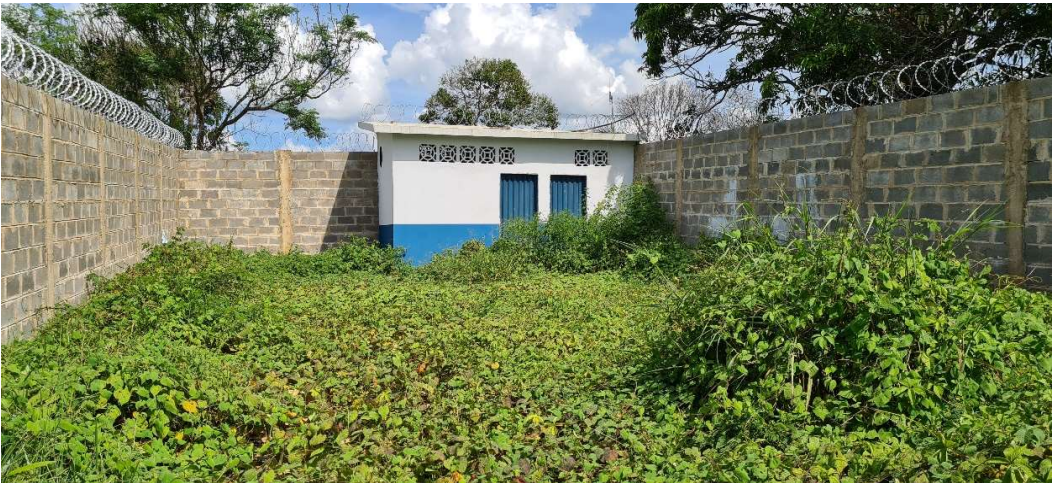
FOTO 14: TERRENO DO POÇO ARTESIANO SEM MANUTENÇÃO.
