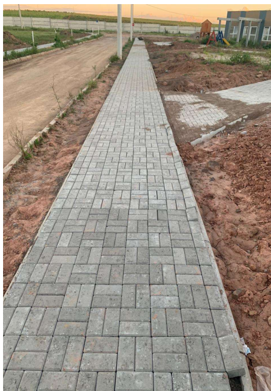
FOTO 18: CALÇADA RUA N
