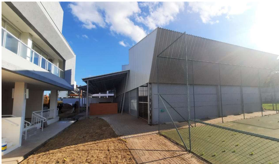
FOTO 01: QUADRA DE TÊNIS COBERTA – PINTURA E ACABAMENTOS
