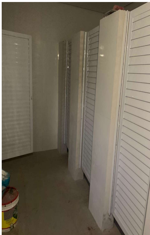
FOTO 08: ÁREA VERDE 06 – VESTIÁRIO 2 – ESQUADRIAS INTERNAS
