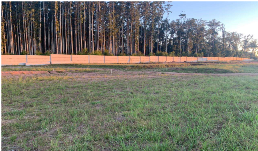
FOTO 21: EXECUÇÃO DO MURO DE FECHAMENTO SENTIDO OESTE – LESTE
