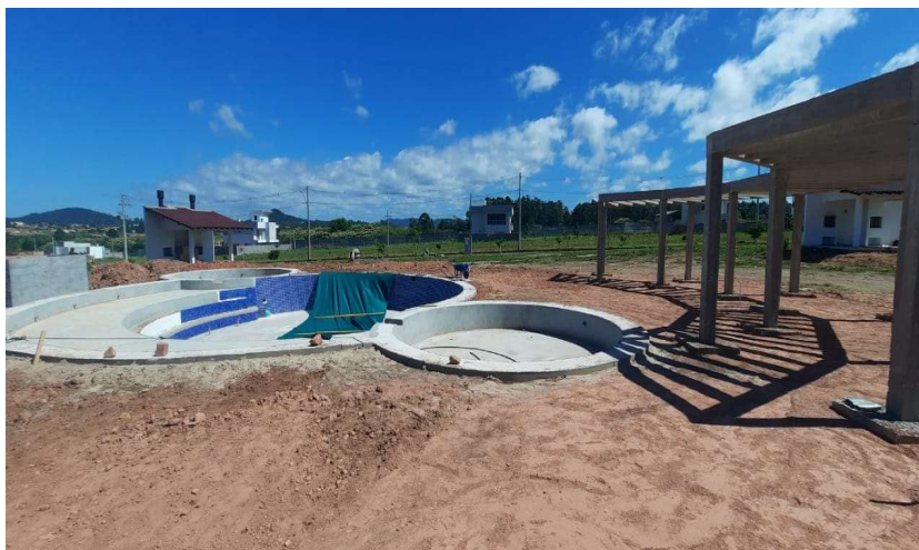
FOTO 05: ÁREA VERDE 04 – PISCINA – REVESTIMENTO INTERNO, CASA DE MÁQUINAS E NIVELAMENTO DO TERRENO
