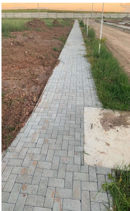
FOTO 20: ACABAMENTOS EM CAIXAS
