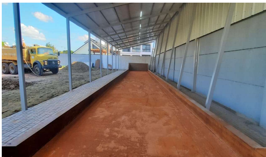
FOTO 04: CANCHA DE BOCHA – COBERTURA E ILUMINAÇÃO
