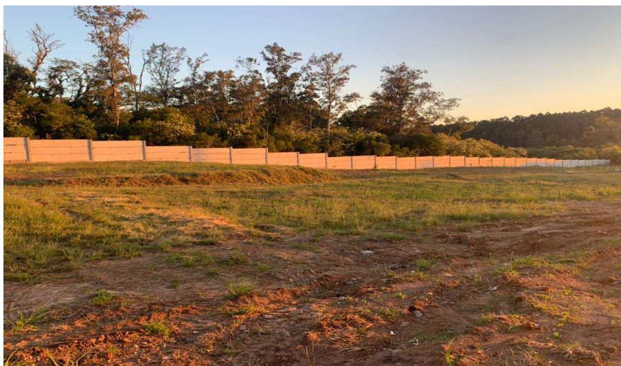
FOTO 22: EXECUÇÃO DO MURO DE FECHAMENTO SENTIDO LESTE - OESTE
