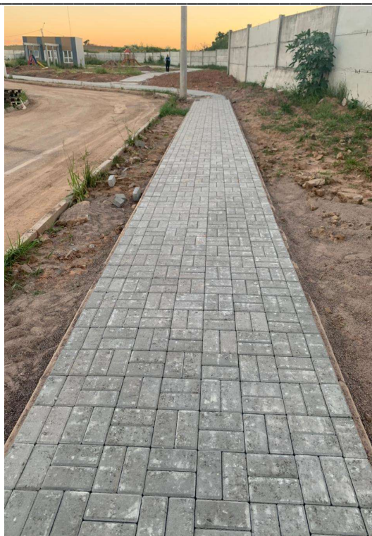
FOTO 19: CALÇADA RUA O
