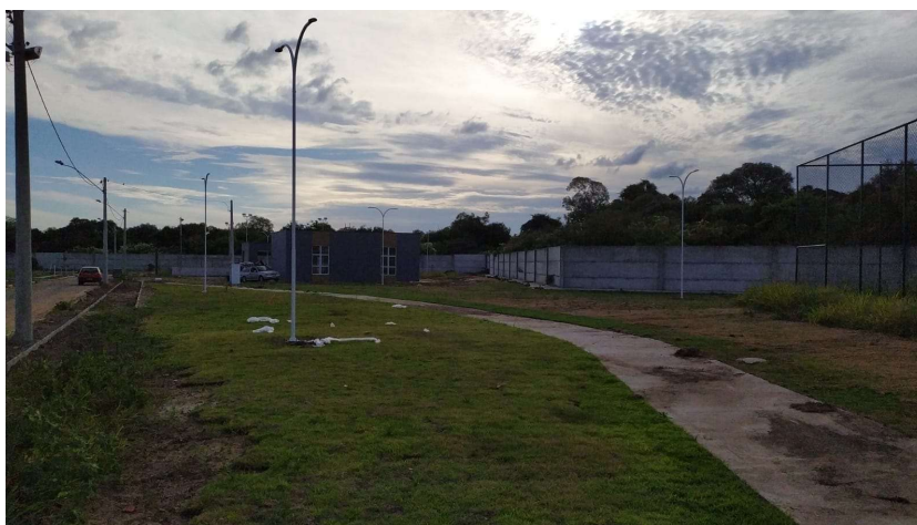
FOTO 06: ÁREA VERDE 4, 6 E 7– POSTES DE ILUMINAÇÃO
