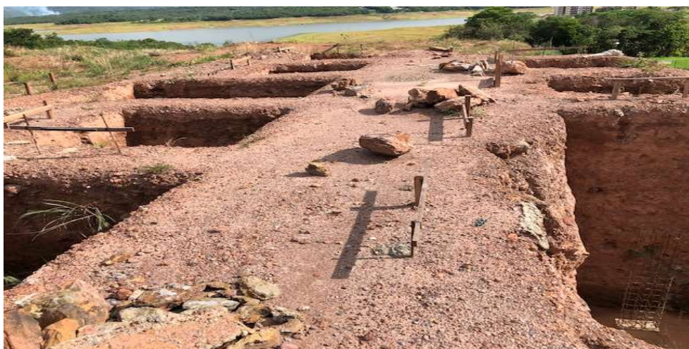
FOTO 02: TORRE E – ESCAVAÇÃO, ARMAÇÃO E CONCRETAGEM DE SAPATAS
