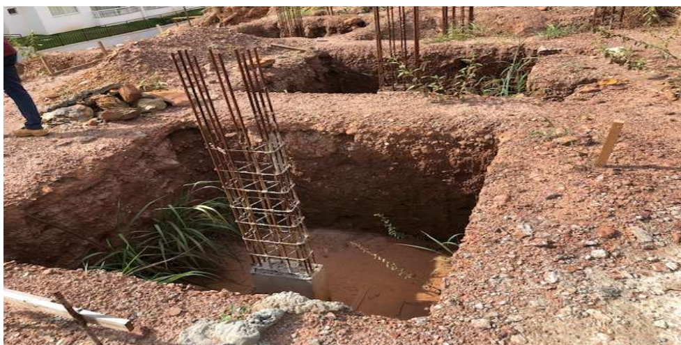
FOTO 08: TORRE E – ESCAVAÇÃO, ARMAÇÃO E CONCRETAGEM DE SAPATAS
