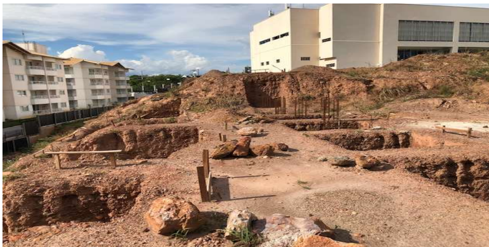
FOTO 01: TORRE E – ESCAVAÇÃO, ARMAÇÃO E CONCRETAGEM DE SAPATAS
