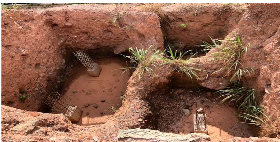
FOTO 06: TORRE E – ESCAVAÇÃO, ARMAÇÃO E CONCRETAGEM DE SAPATAS
