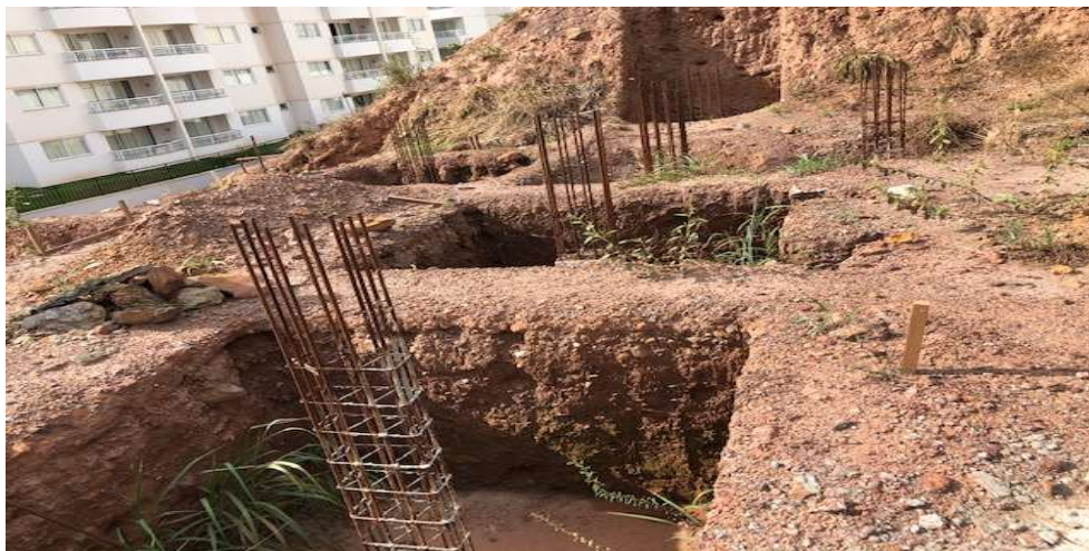
FOTO 07: TORRE E – ESCAVAÇÃO, ARMAÇÃO E CONCRETAGEM DE SAPATAS
