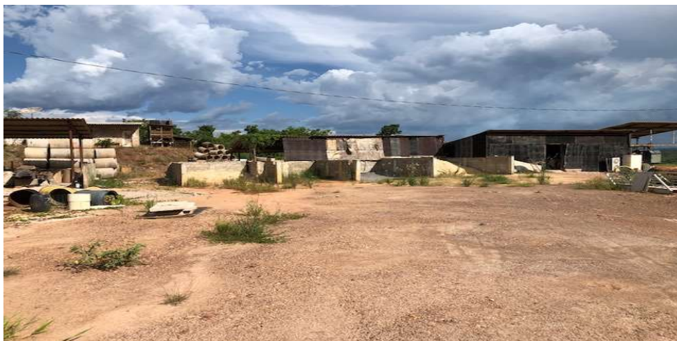
FOTO 14: CANTEIRO DE OBRAS
