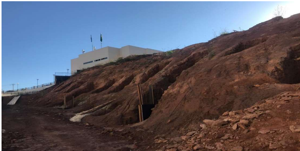
FOTO 10: TORRE E – ESCAVAÇÃO, ARMAÇÃO E CONCRETAGEM DE SAPATAS
