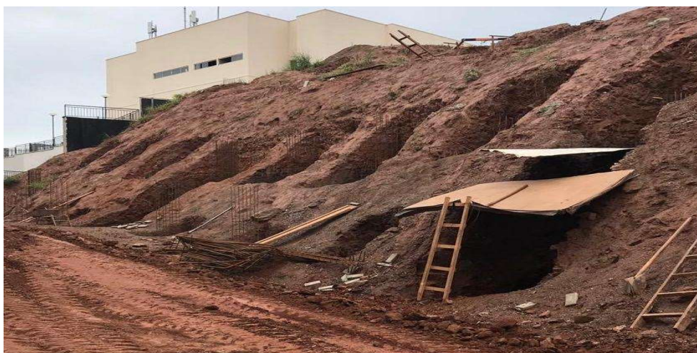
FOTO 11: TORRE E – ESCAVAÇÃO, ARMAÇÃO E CONCRETAGEM DE SAPATAS
