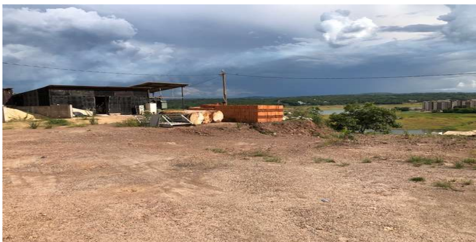
FOTO 15: CANTEIRO DE OBRAS
