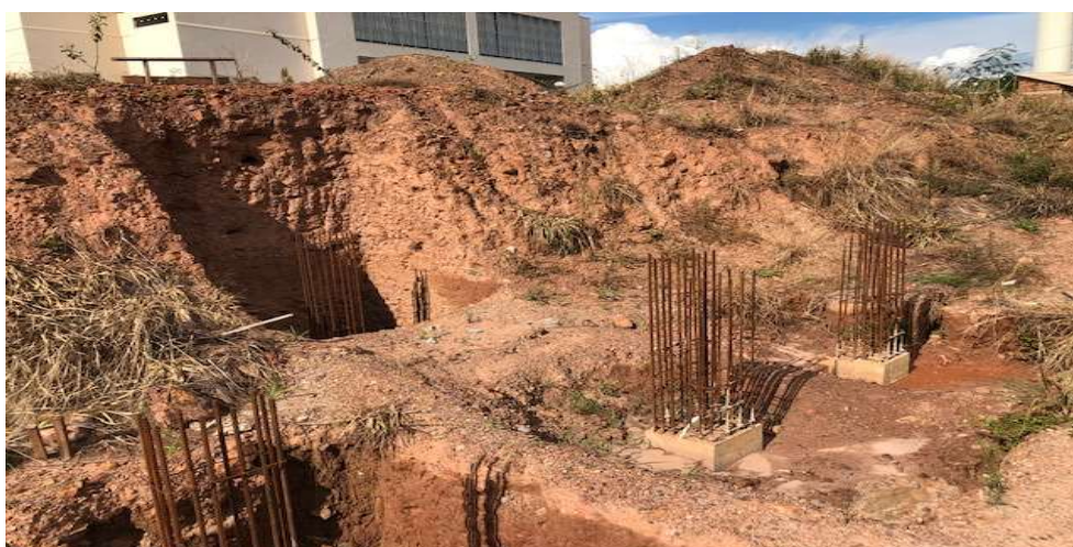
FOTO 03: TORRE E – ESCAVAÇÃO, ARMAÇÃO E CONCRETAGEM DE SAPATAS
