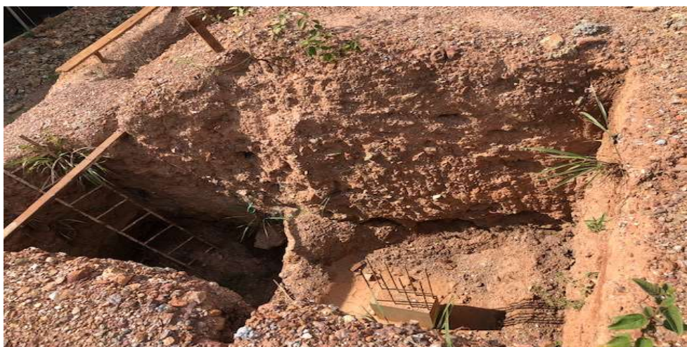
FOTO 05: TORRE E – ESCAVAÇÃO, ARMAÇÃO E CONCRETAGEM DE SAPATAS
