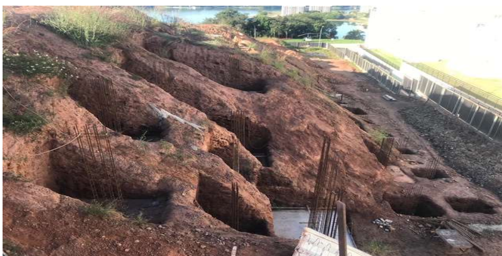
FOTO 09: TORRE E – ESCAVAÇÃO, ARMAÇÃO E CONCRETAGEM DE SAPATAS
