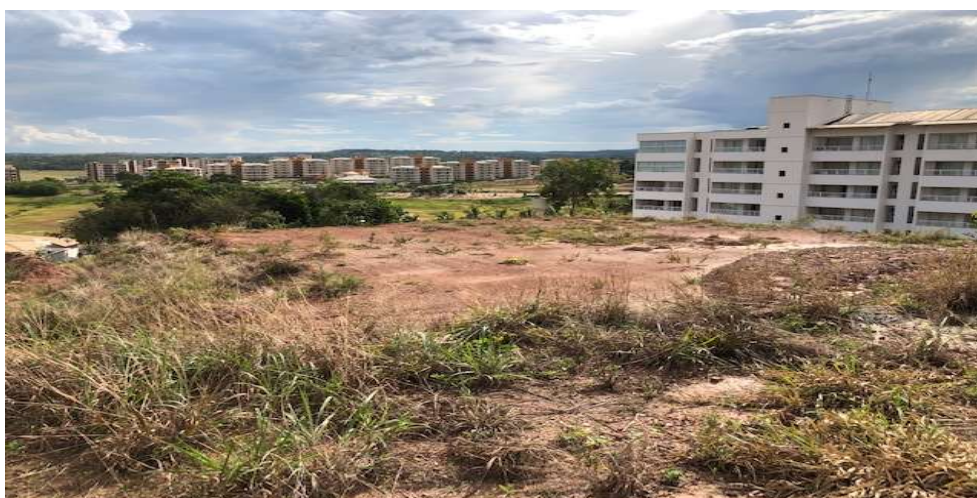
FOTO 12: TORRE E, F – TERRAPLENAGEM
