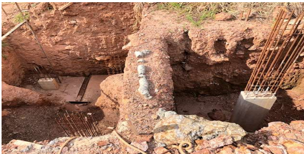
FOTO 04: TORRE E – ESCAVAÇÃO, ARMAÇÃO E CONCRETAGEM DE SAPATAS
