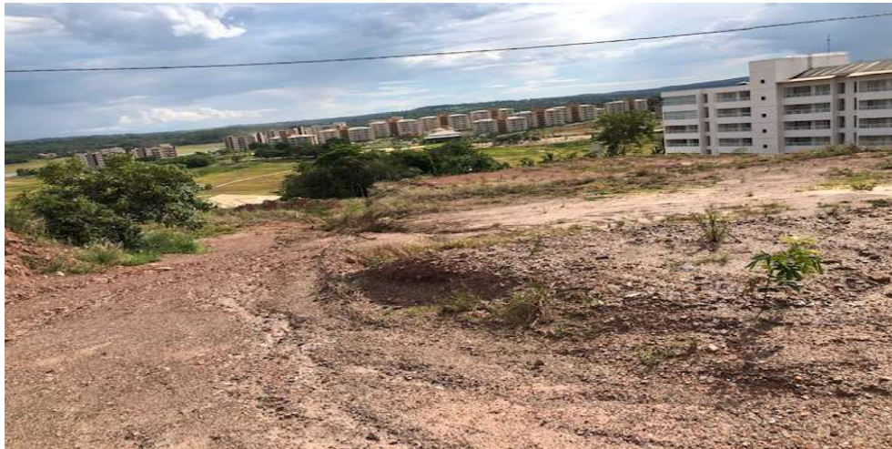
FOTO 13: TORRE E, F – TERRAPLENAGEM
