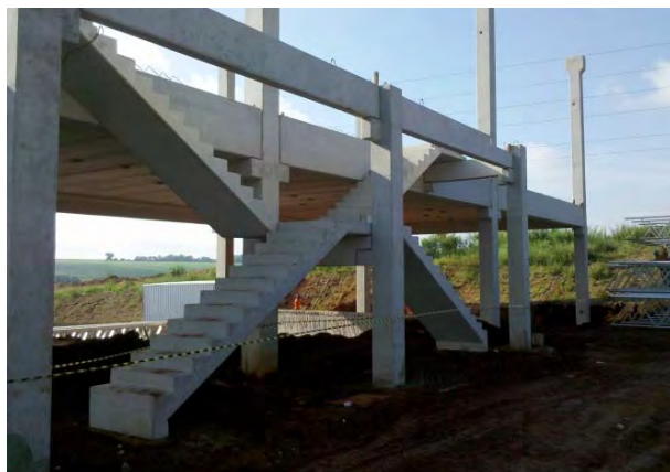
Escadas do mezanino- G1
