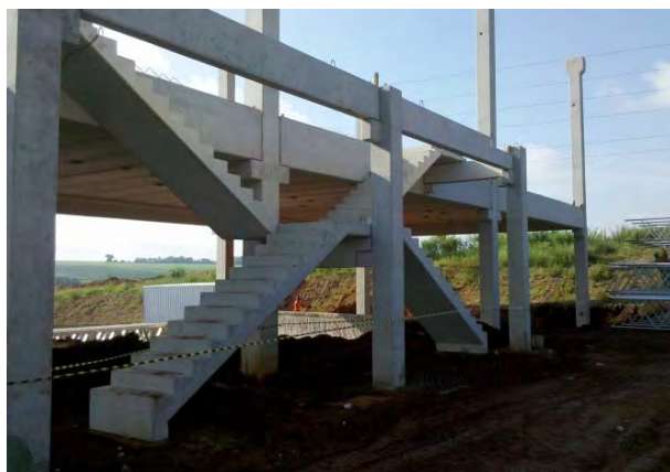
Escadas do mezanino- G1
