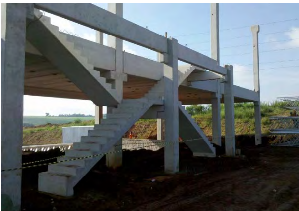
Escadas do mezanino- G1
