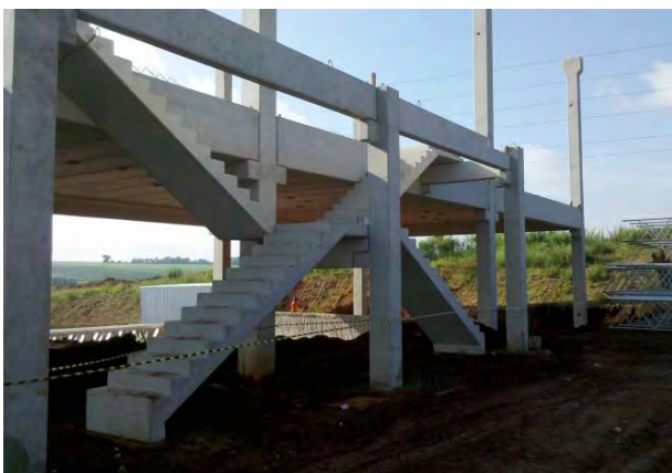
Escadas do mezanino- G1
