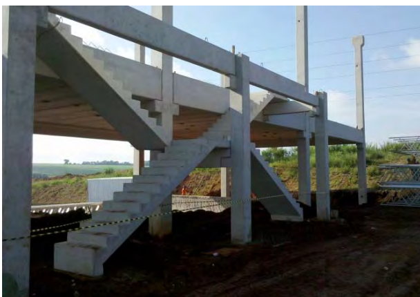
Escadas do mezanino- G1
