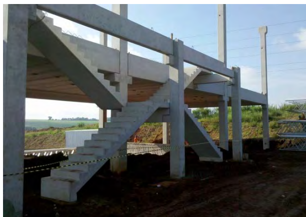
Escadas do mezanino- G1
