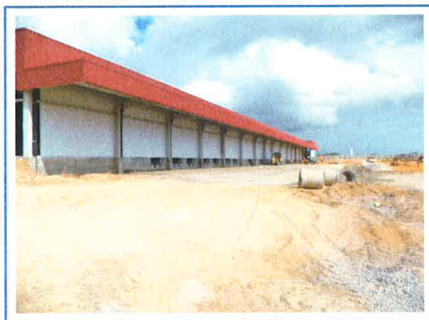
FOTO 14– VISTA PARCIAL INTERNA
