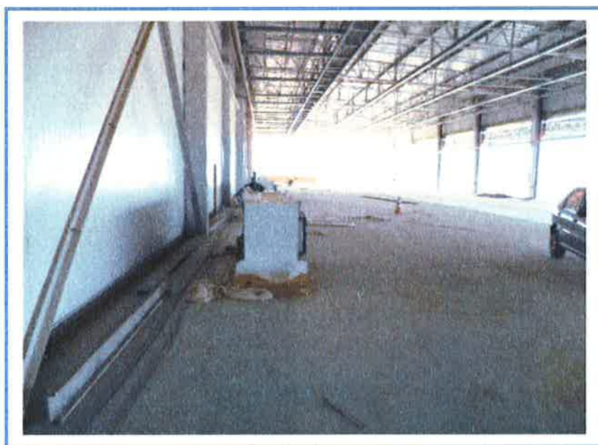
FOTO 9 – VISTA PARCIAL INTERNA
