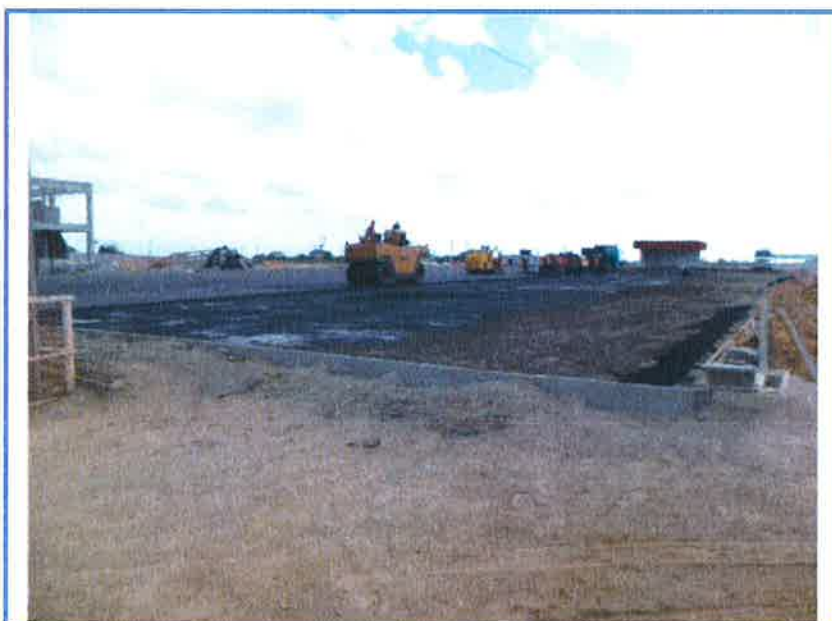
FOTO 6 – VISTA PARCIAL INTERNA
