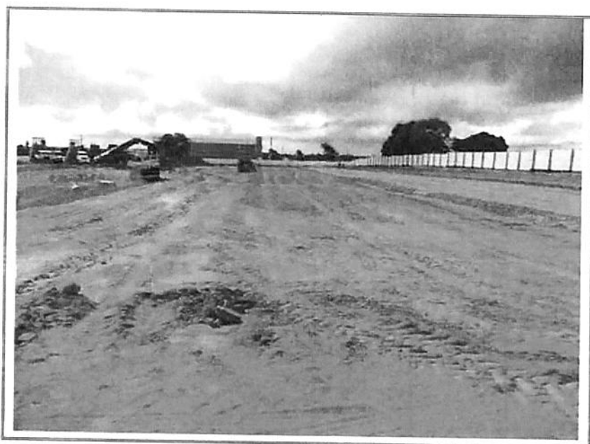
FOTO 7 – VISTA PARCIAL INTERNA
