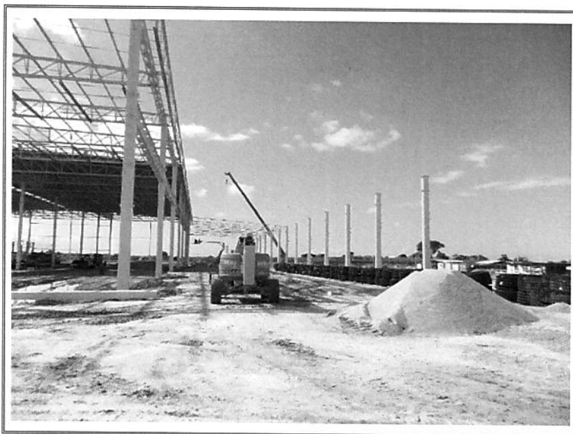
FOTO 9 – VISTA PARCIAL INTERNA
