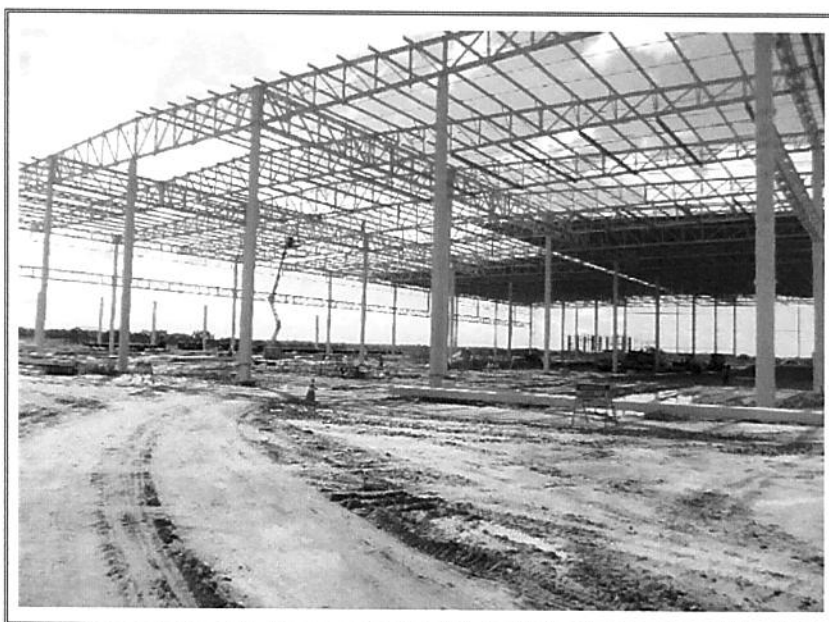
FOTO 8 – VISTA PARCIAL INTERNA
