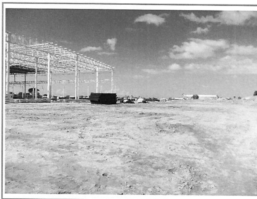
FOTO 15 – VISTA PARCIAL INTERNA
