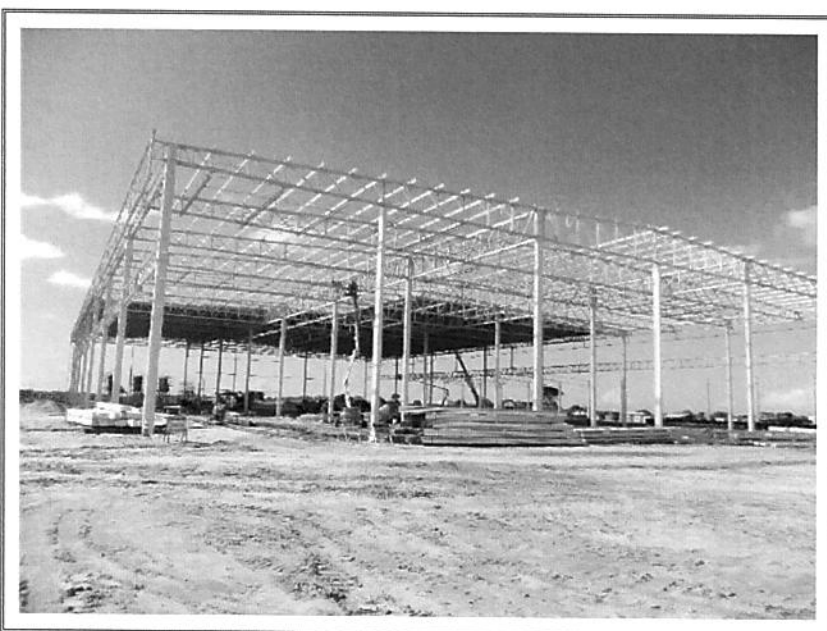
FOTO 12 – VISTA PARCIAL INTERNA
