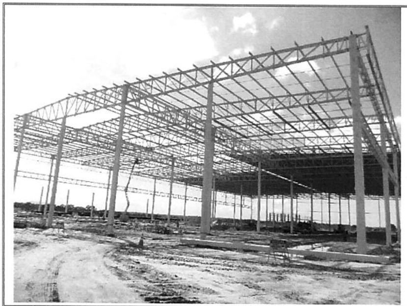
FOTO 7 – VISTA PARCIAL INTERNA
