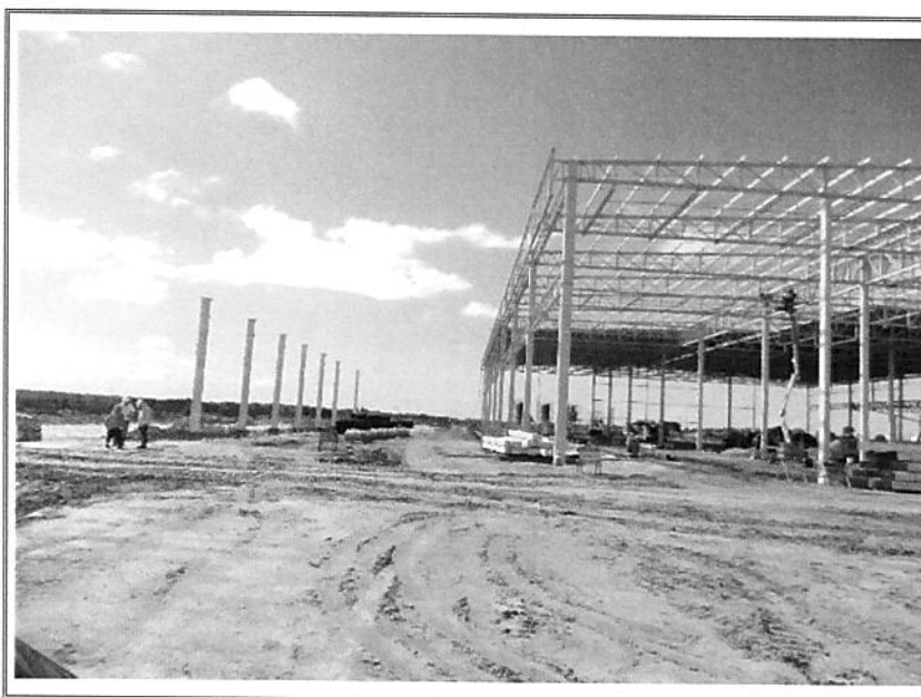
FOTO 11 – VISTA PARCIAL INTERNA
