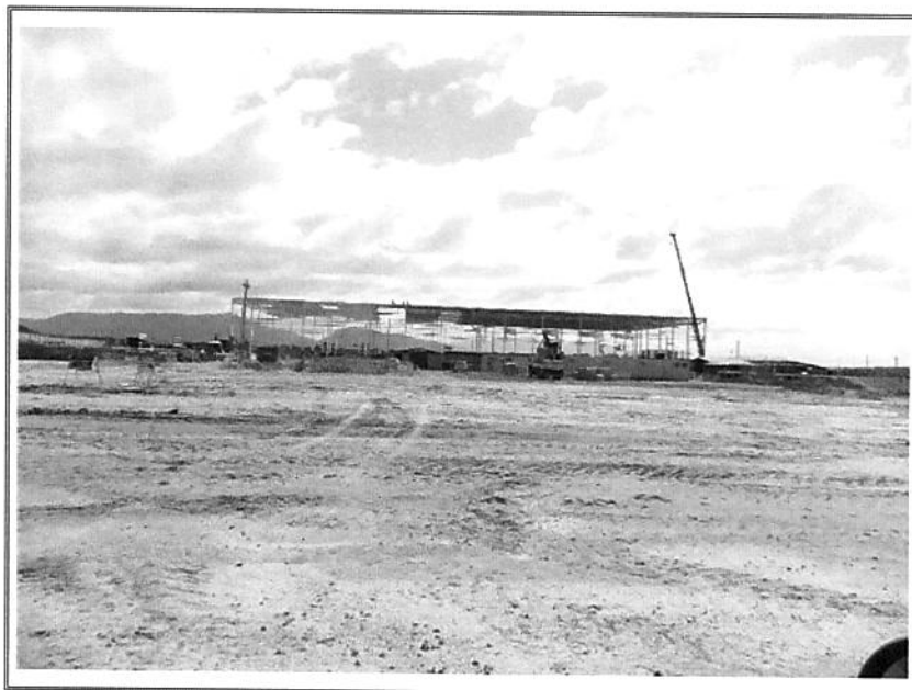
FOTO 5 – VISTA PARCIAL INTERNA
