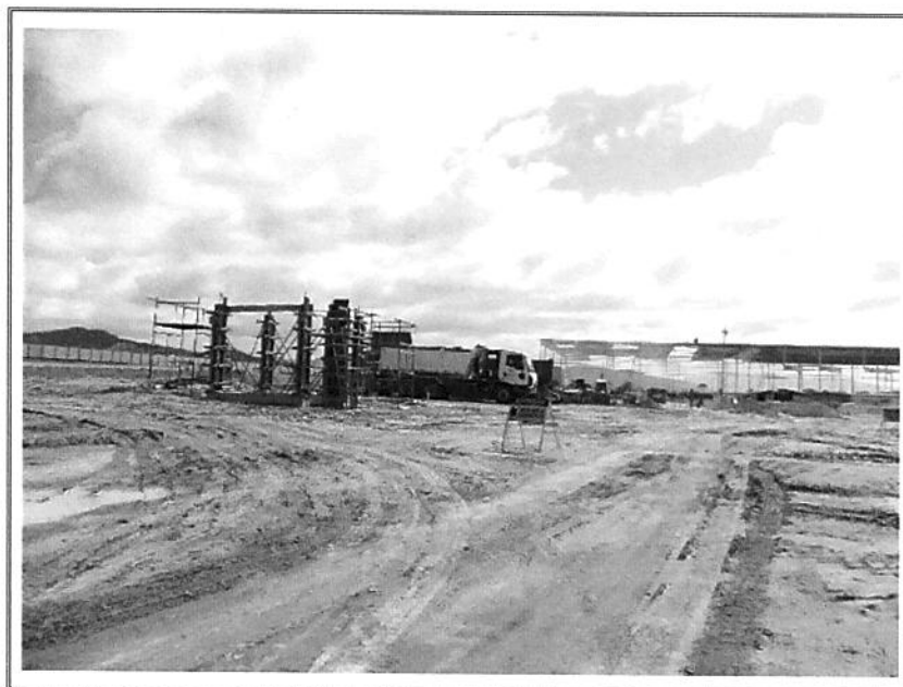
FOTO 3 – VISTA PARCIAL INTERNA
