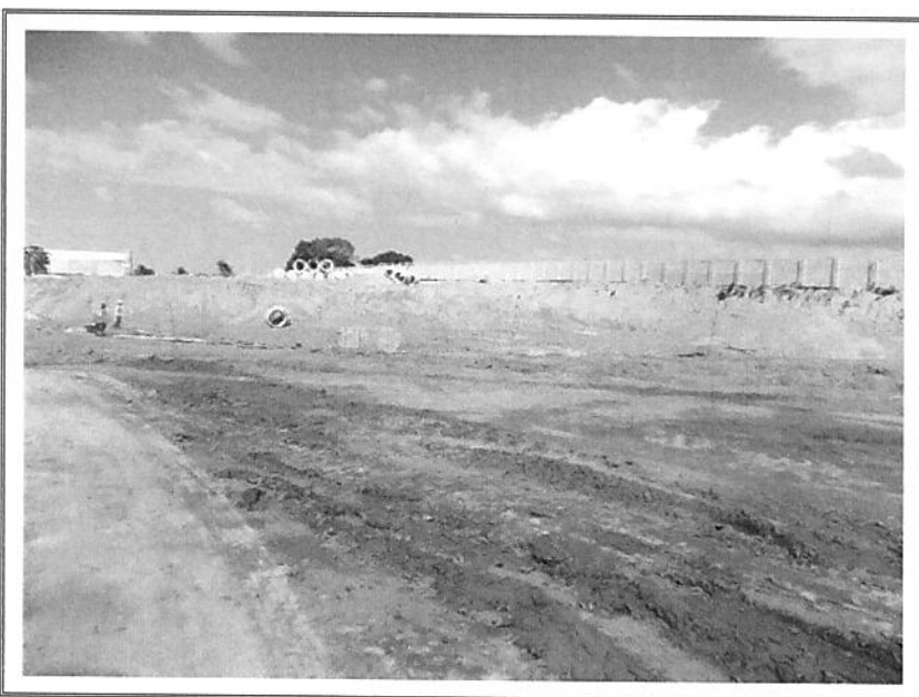
FOTO 10 – VISTA PARCIAL INTERNA
