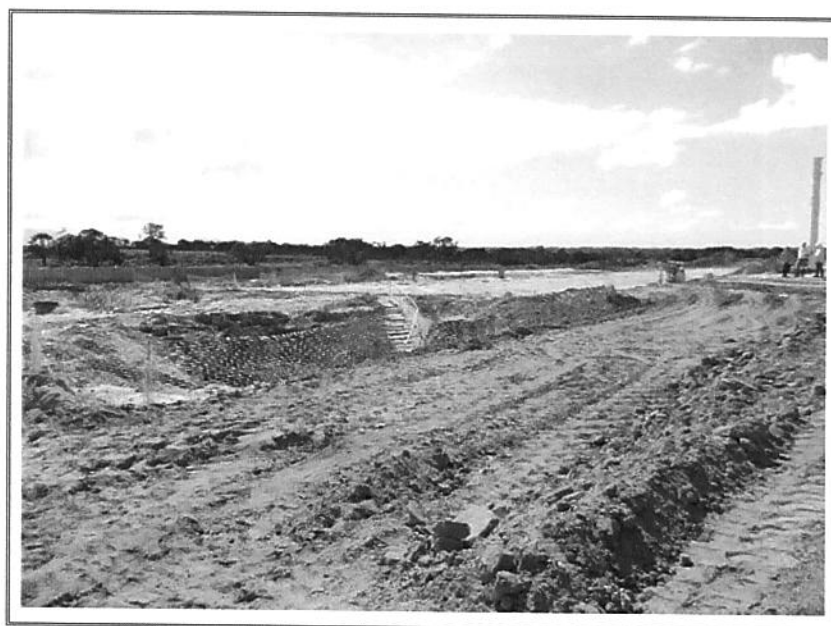
FOTO 14 – VISTA PARCIAL INTERNA
