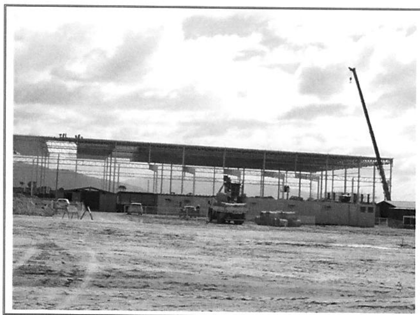
FOTO 6 – VISTA PARCIAL INTERNA
