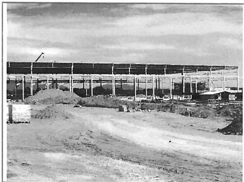
FOTO 7 – VISTA PARCIAL INTERNA
