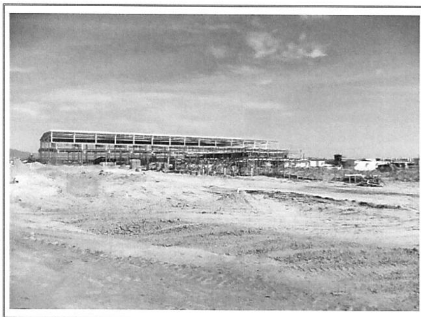
FOTO 5 – VISTA PARCIAL INTERNA
