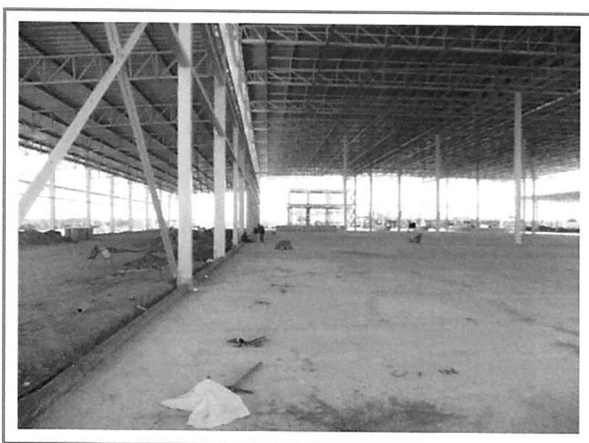
FOTO 8 – VISTA PARCIAL INTERNA
