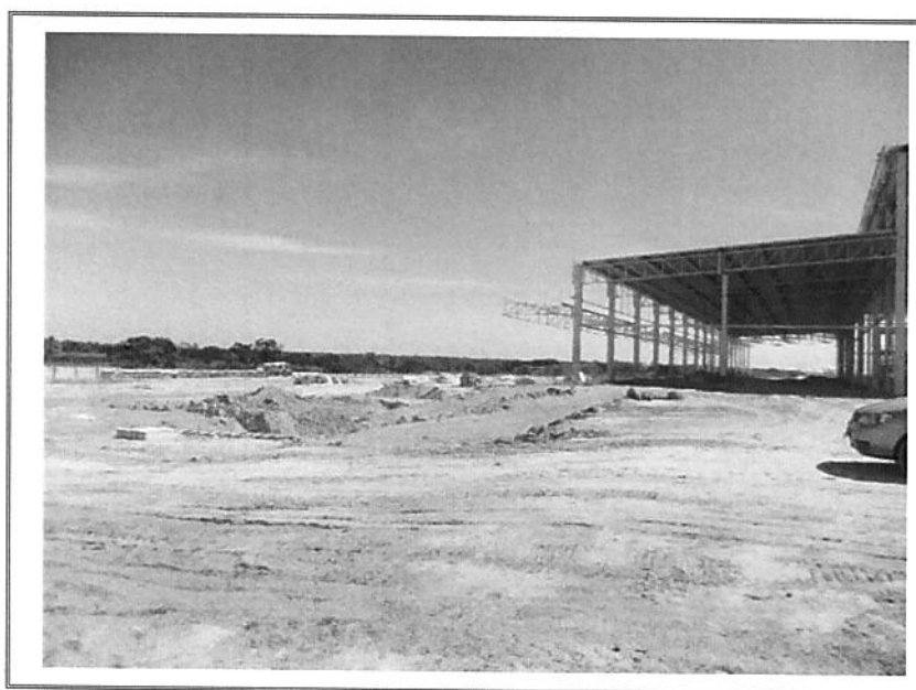
FOTO 12 – VISTA PARCIAL INTERNA
