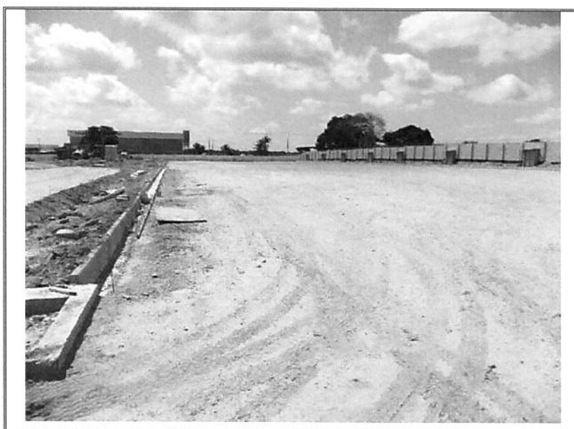
FOTO 6 – VISTA PARCIAL INTERNA
