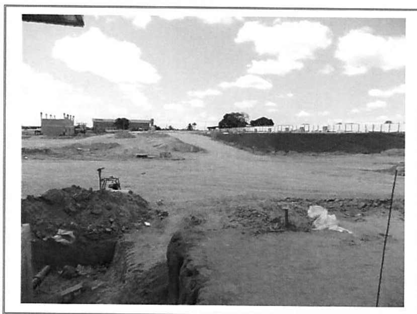
FOTO 12 – VISTA PARCIAL INTERNA
