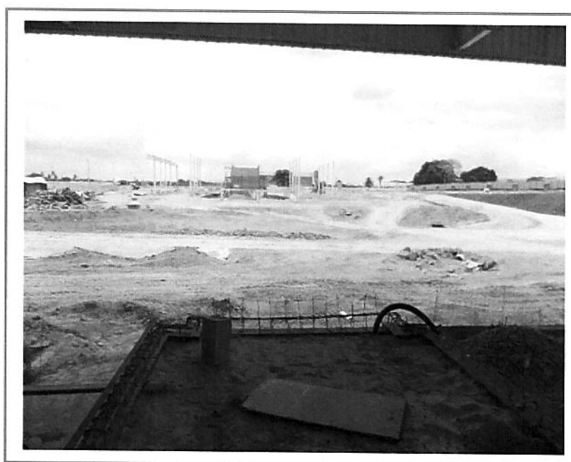
FOTO 10 – VISTA PARCIAL INTERNA
