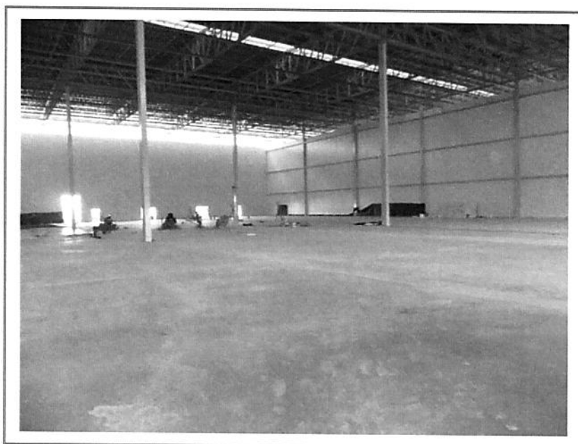
FOTO 11 – VISTA PARCIAL INTERNA
