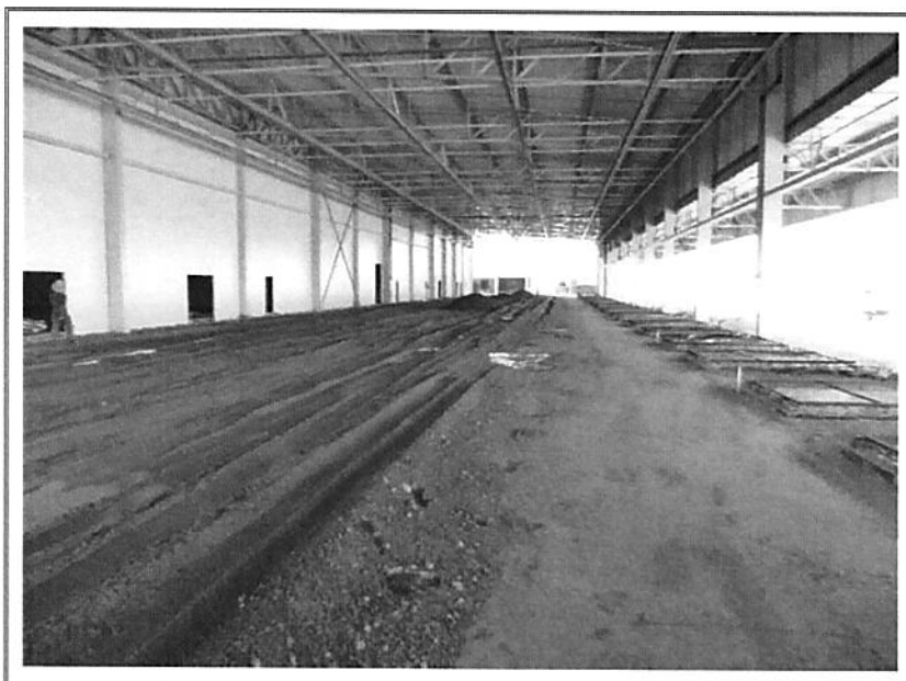
FOTO 15 – VISTA PARCIAL INTERNA
