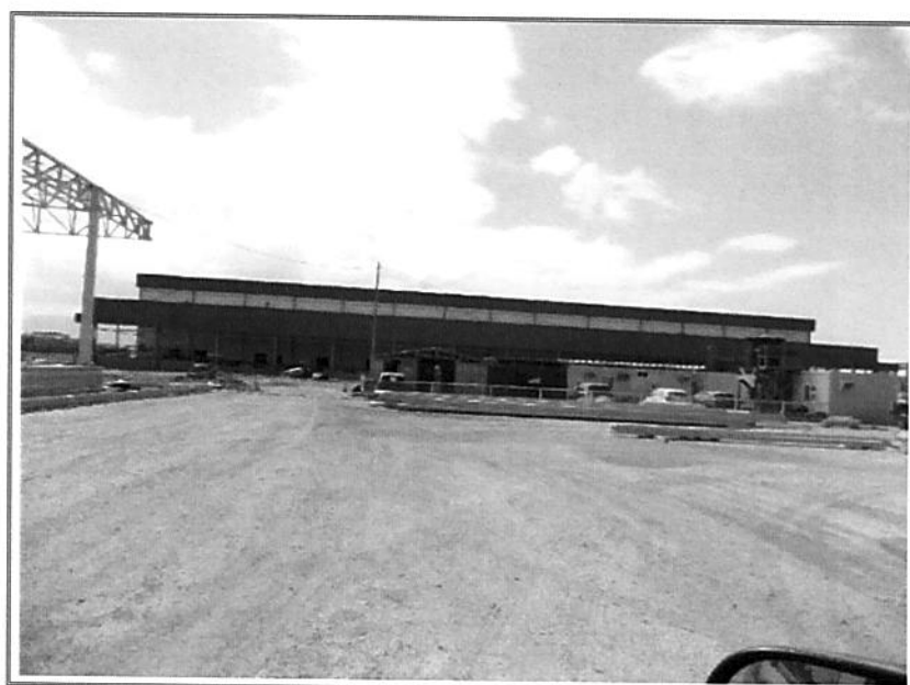
FOTO 6 – VISTA PARCIAL INTERNA
