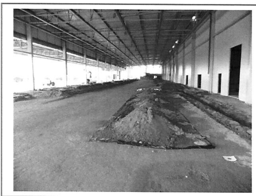
FOTO 16 – VISTA PARCIAL INTERNA
