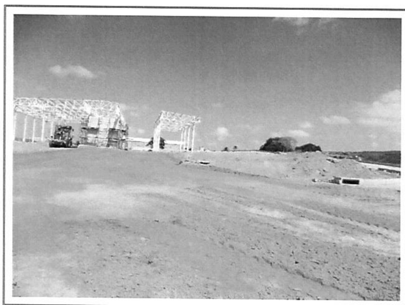
FOTO 8 – VISTA PARCIAL INTERNA
