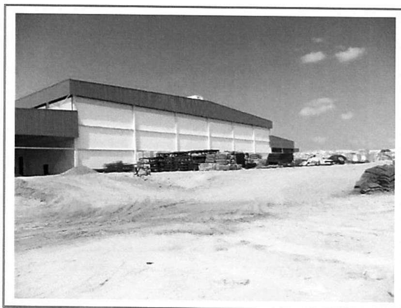
FOTO 14– VISTA PARCIAL INTERNA
