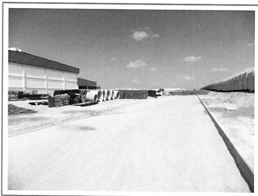
FOTO 11 – VISTA PARCIAL INTERNA
