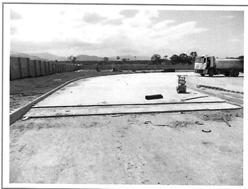
FOTO 12 – VISTA PARCIAL INTERNA
