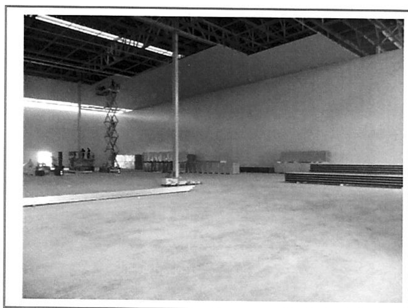
FOTO 20 – VISTA PARCIAL INTERNA
