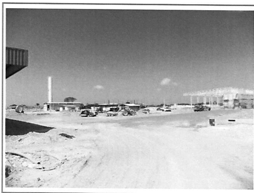
FOTO 22 – VISTA PARCIAL INTERNA
