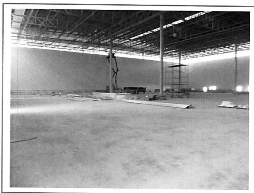
FOTO 19 – VISTA PARCIAL INTERNA
