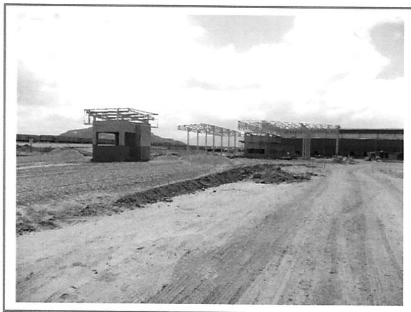
FOTO 4 – VISTA PARCIAL INTERNA
