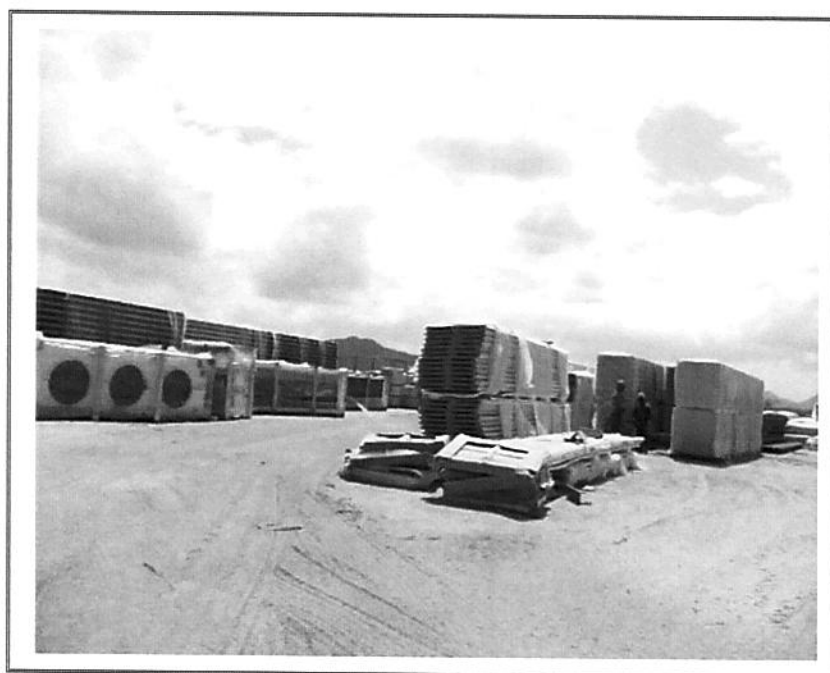
FOTO 10 – VISTA PARCIAL INTERNA
