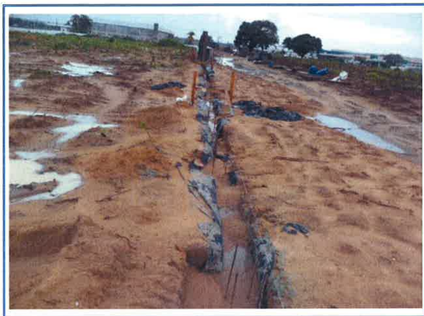
FOTO 11 – VISTA PARCIAL INTERNA
