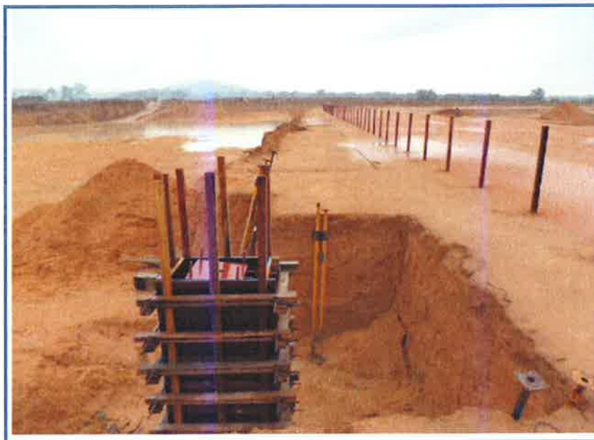
FOTO 7 – VISTA PARCIAL INTERNA
