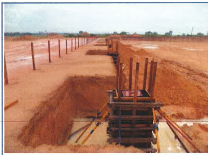
FOTO 6 – VISTA PARCIAL INTERNA
