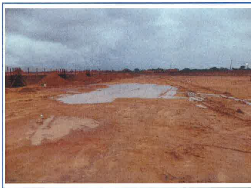
FOTO 5 – VISTA PARCIAL INTERNA
