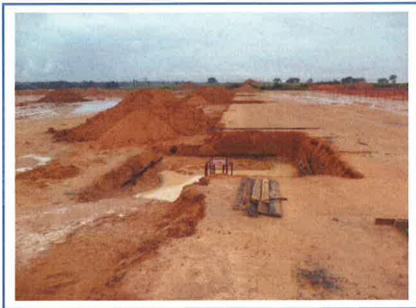
FOTO 9 – VISTA PARCIAL INTERNA
