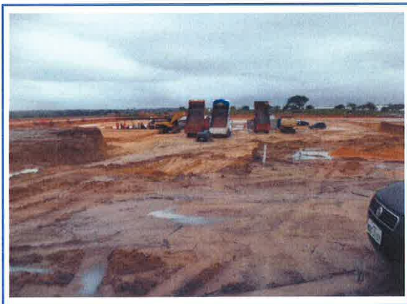
FOTO 3 – VISTA PARCIAL INTERNA
