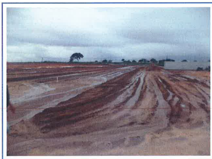
FOTO 2 – VISTA PARCIAL INTERNA
