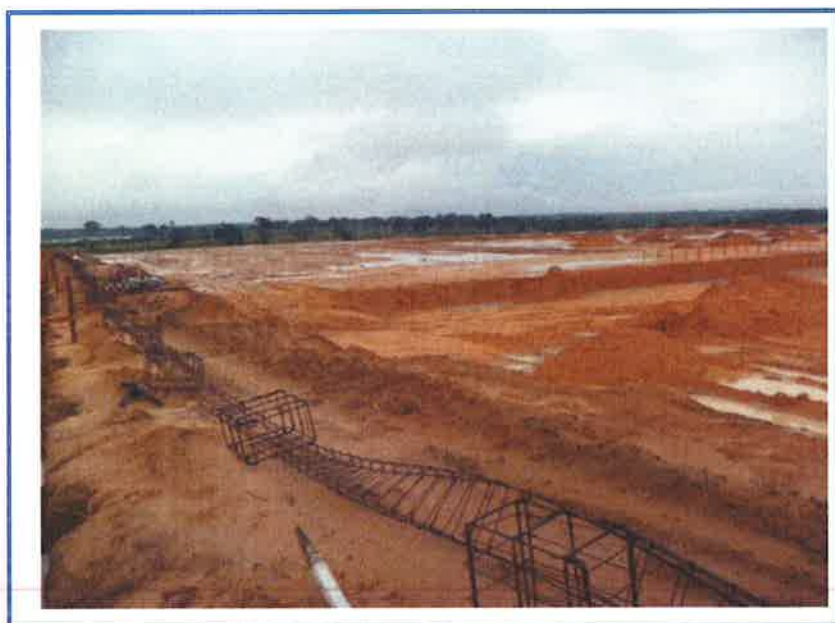
FOTO 12 – VISTA PARCIAL INTERNA
