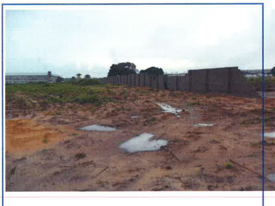
FOTO 10 – VISTA PARCIAL INTERNA
