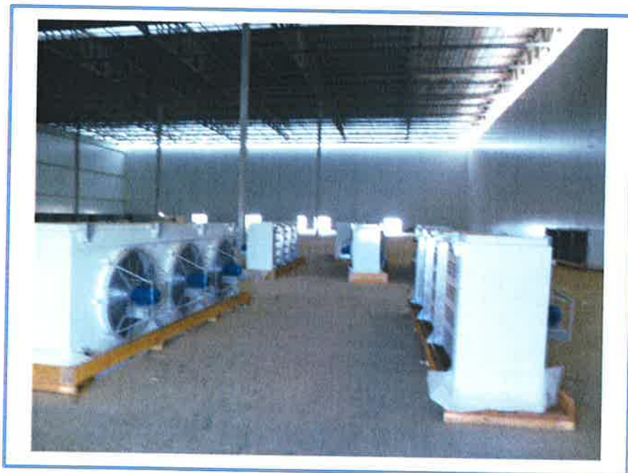
FOTO 14– VISTA PARCIAL INTERNA
