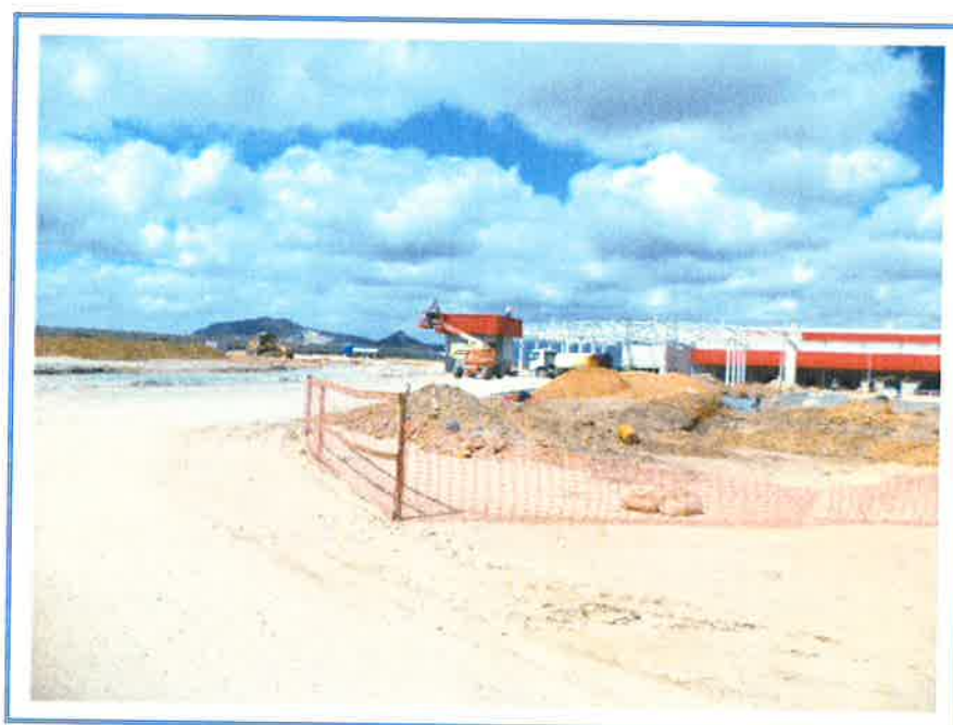
FOTO 4 – VISTA PARCIAL INTERNA
