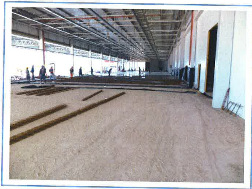
FOTO 13 – VISTA PARCIAL INTERNA
