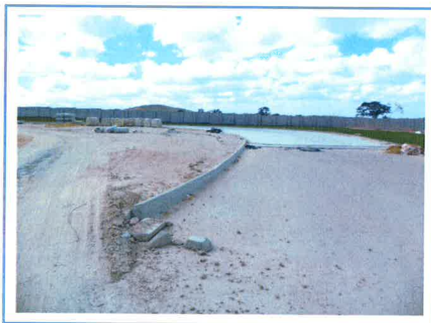
FOTO 8 – VISTA PARCIAL INTERNA
