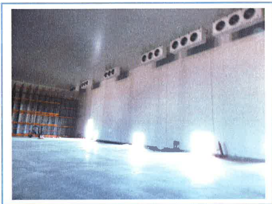
FOTO 11 – VISTA PARCIAL INTERNA
