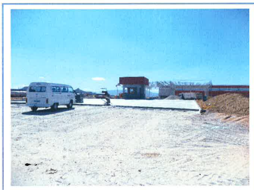
FOTO 2 - VISTA PARCIAL INTERNA
