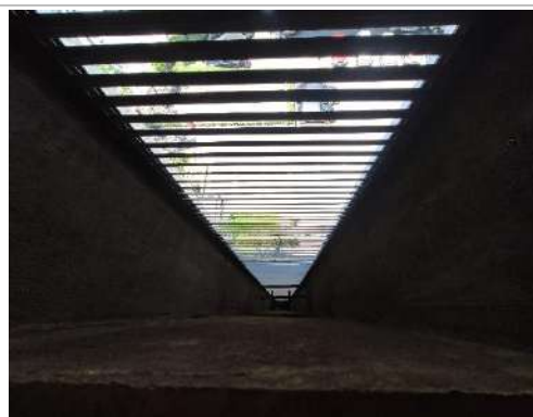
Passagem de ar entre os pavimentos
