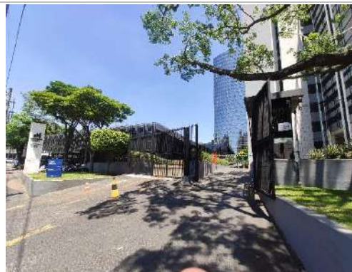
Acesso de veículos
