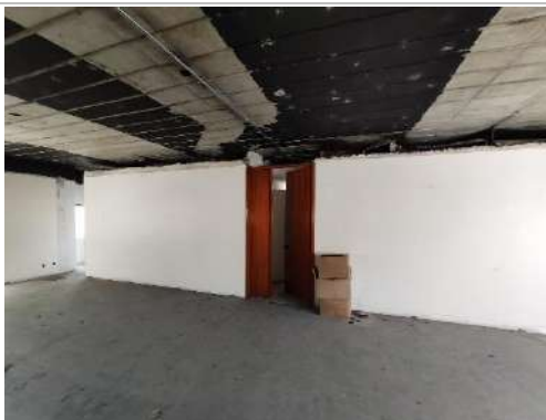
Área de corredor de acesso aos banheiros e copa (conjunto 11)
