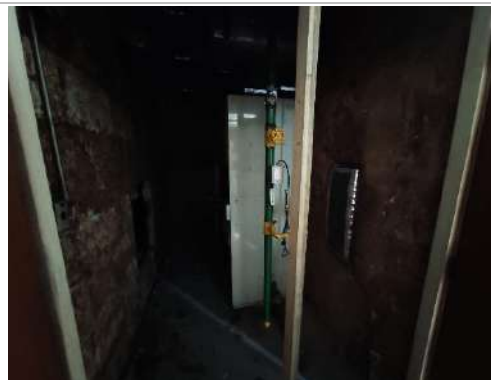
Controle de Ar-condicionado (conjunto 11)
