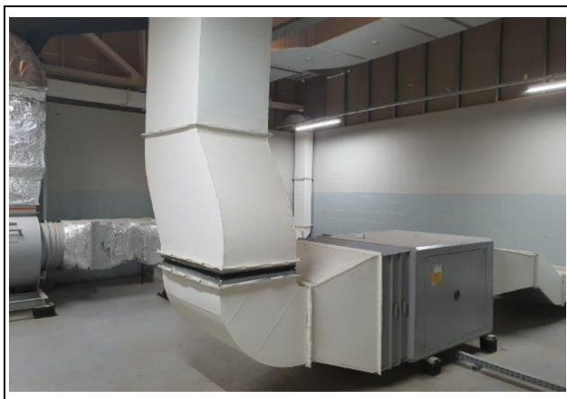
VISTA DA CASA DE MÁQUINAS
