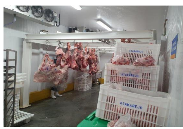
VISTA DA CÂMARA FRIA / AÇOUGUE
