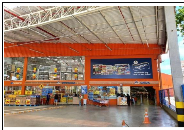
VISTA DA FACHADA LOJA
