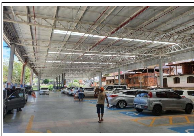
VISTA DO ESTACIONAMENTO COBERTO
