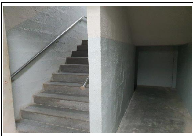
VISTA DO ACESSO AO ADMINISTRATIVO
