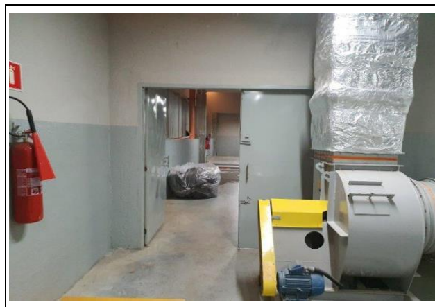
VISTA DA CASA DE MÁQUINAS
