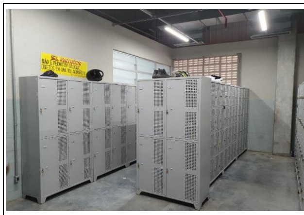
VISTA DO SANITÁRIO / VESTIÁRIO
