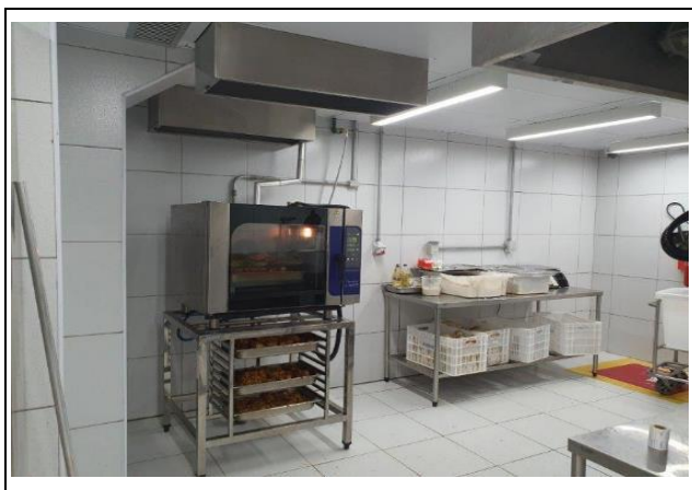
VISTA DO REFEITÓRIO
