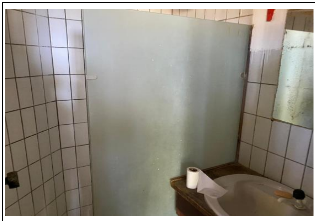
VISTA DA CASA DE APOIO (WC)
