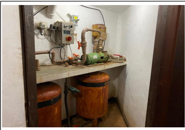
VISTA DO PORÃO (CASA DE MÁQUINAS)
